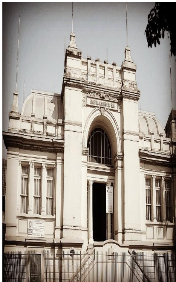
Figura 1: Fachada MIS/RJ prédio da praça xv
