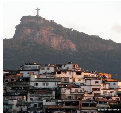
Figura 1: Vista da favela com o Cristo Redentor ao fundo. (Fonte: Caos Carioca.)
