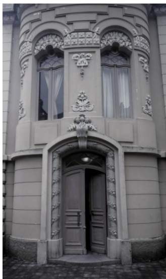
Figura 119 - Detalhe do primeiro e segundo pavimento do OAM/UFRGS – fotografia da autora.
