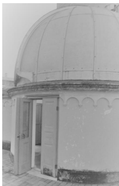
Figura 125 - Detalhe da cúpula equatorial OAM/UFRGS – fotografia da autora
