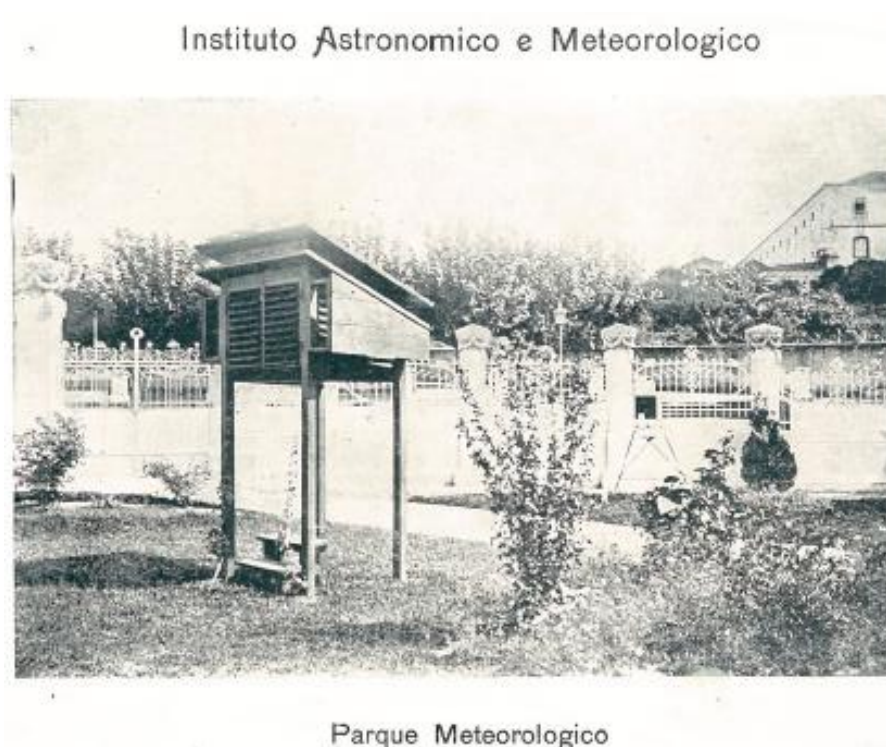
Figura 132 - Detalhe do abrigo meteorológico montado nos jardins do Observatório (PAROBÉ, 1909 p.188-189).
