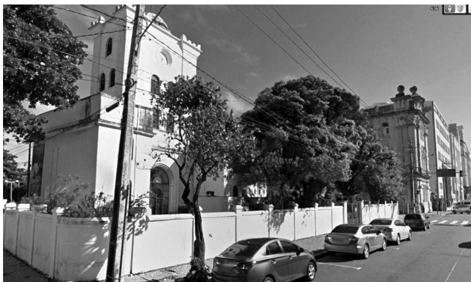
Figura 47 - Parte posterior do Prédio da Capitania dos Portos que dá para Av. Alfredo Lisboa - a partir de imagem do Google Earth em dez. 2018
