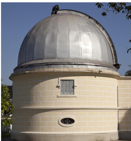
Figura 81 - Cúpula metálica da Société Anonyme des Anciens Établissements Cail – Paris, 1889, paga pelo Imperador Pedro II. Atualmente abriga a luneta Equatorial 21, da firma Gustav Heyde, instalada no campus do Observatório Nacional/MAST. Fotografia Digital:Jaime Acioli - acervo MAST
