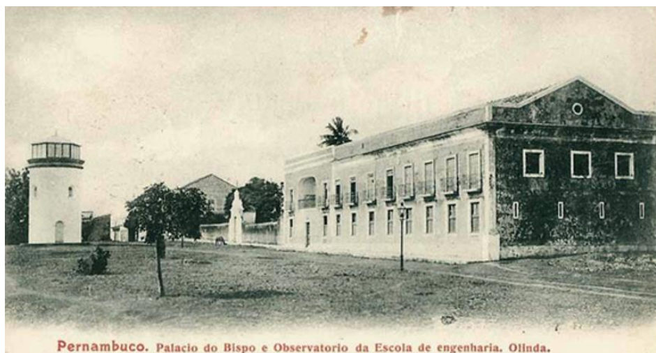
Figura 37 - Detalhe do abrigo do Observatório de Olinda. 1905. Autor: COSTA Ramiro M.
