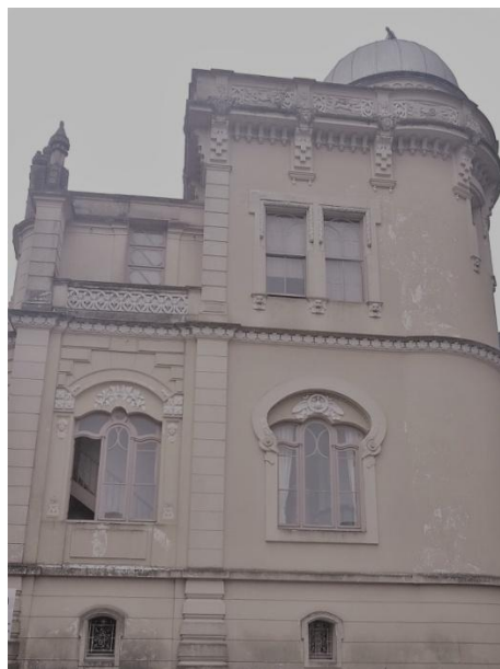
Figura 123 - Lateral da fachada posterior OAM/UFRGS – fotografia da autora
