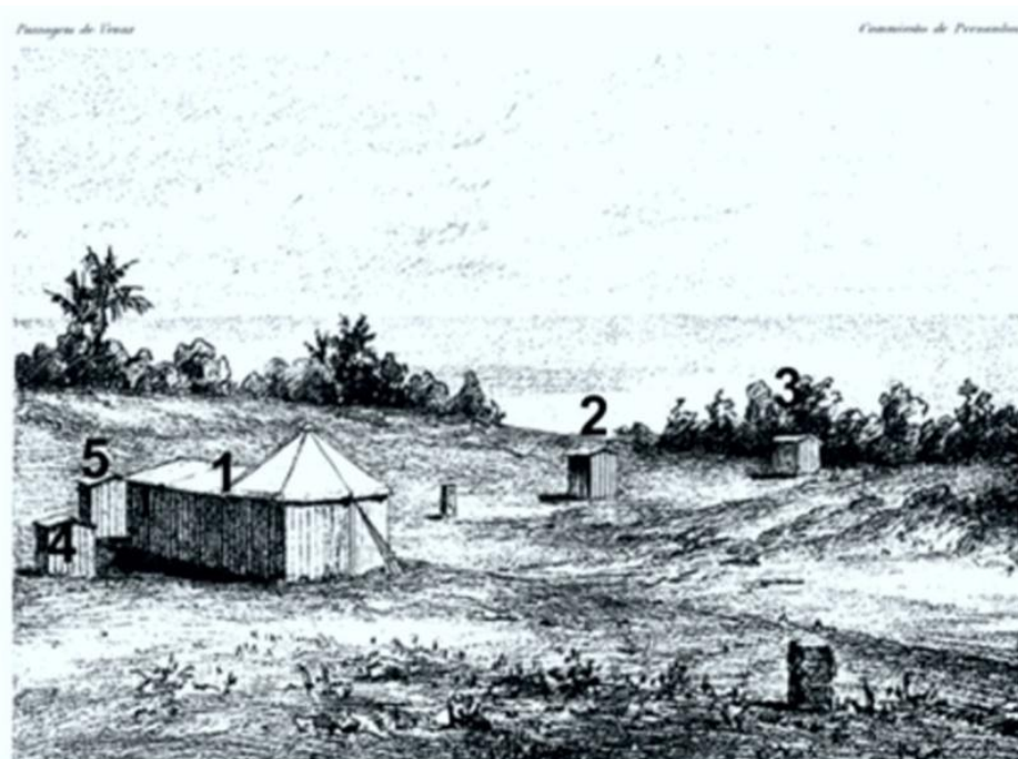
Figura 22 - Detalhe da gravura do observatório de Olinda. Legenda: 1- Observatório; 2- Objetiva da mira; 3- Mira; 4- Colimador Norte; 5- bússola magnética (CRULS, 1887, p.180).
