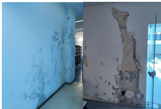
Paredes sendo restauradas devido a danos da chuva
