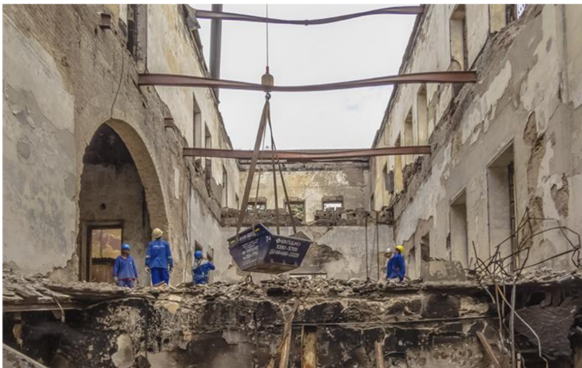
Figura 37 - Processo de remoção de entulho de uma das áreas do Palácio de São Cristóvão
