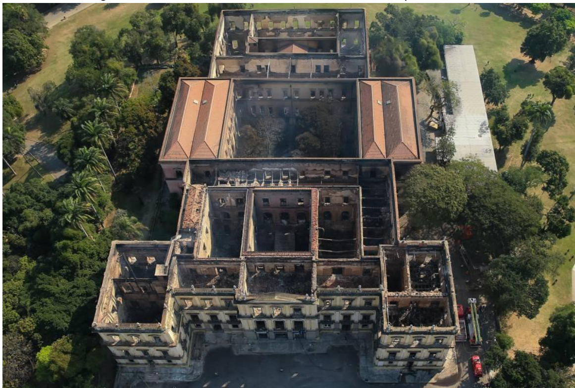
Figura 35 - Vista aérea do Palácio de São Cristóvão após o incêndio
