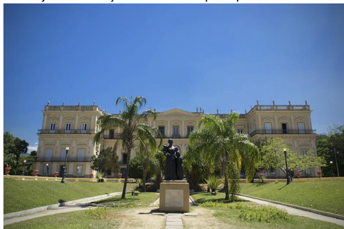
Figura 63: Vista do jardim terraço e da fachada principal do Palácio de São Cristóvão
