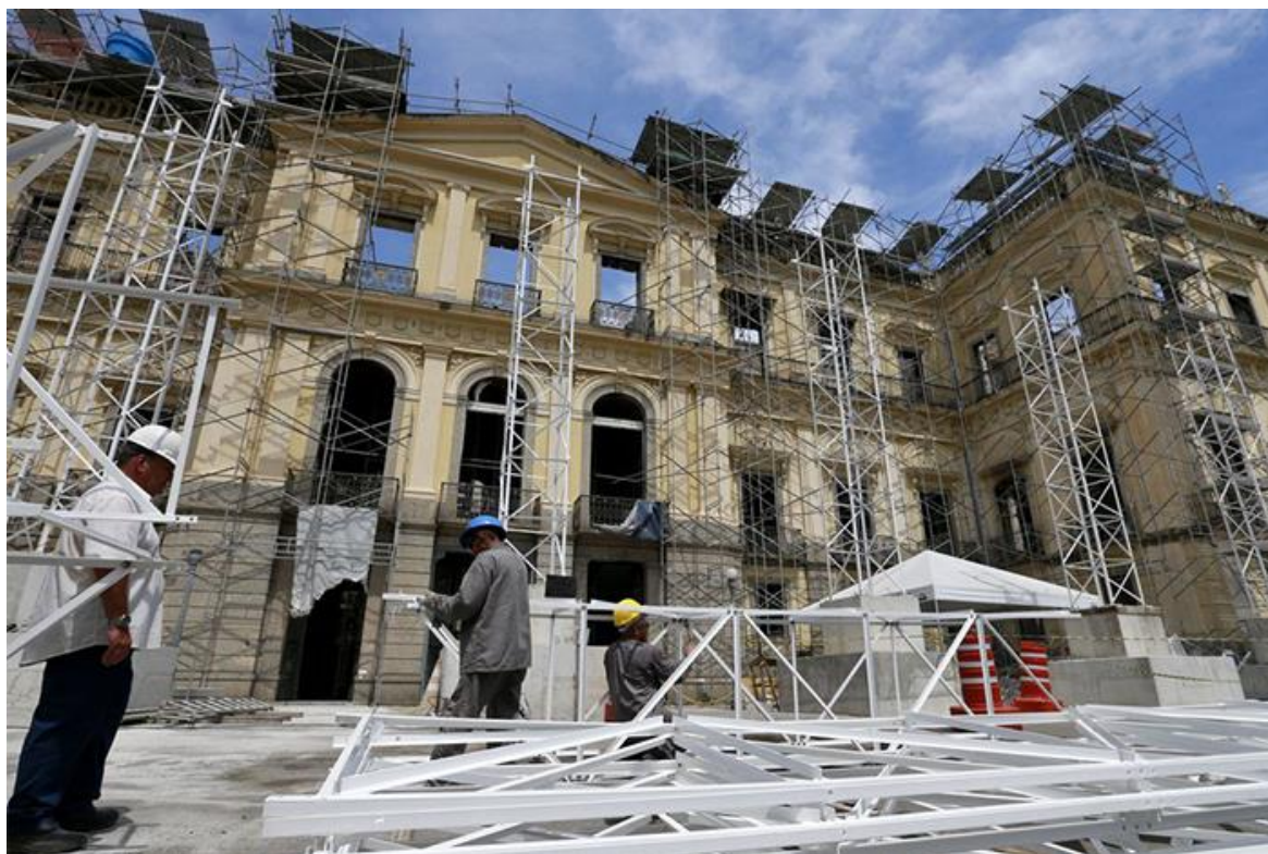
Figura 38: Construção da cobertura metálica sobre o Palácio de São Cristóvão
