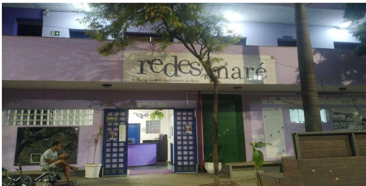
Figura 20 – Registro atual da fachada do prédio central
