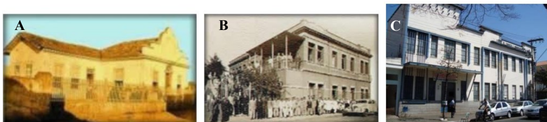
Figura 05. Primeira sede da EFOA (A); Prédio (B) na década de 40 e no momento atual (C)
