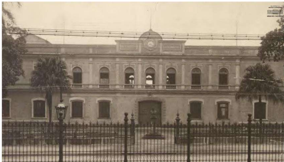
Figura 13: Fachada das Oficinas do Engenho de Dentro. 1933.
