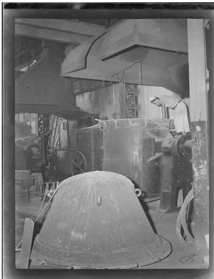
Figura 32: Forjas e chaminés do Complexo de Oficinas do Engenho de Dentro. EFCB.
