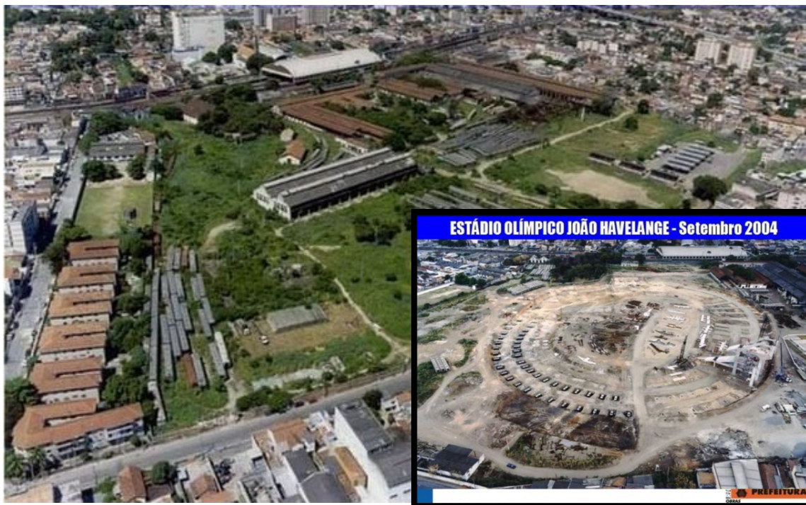
Figura 8: Demolição das Oficinas para construção do Estádio João Havelange. 2004
