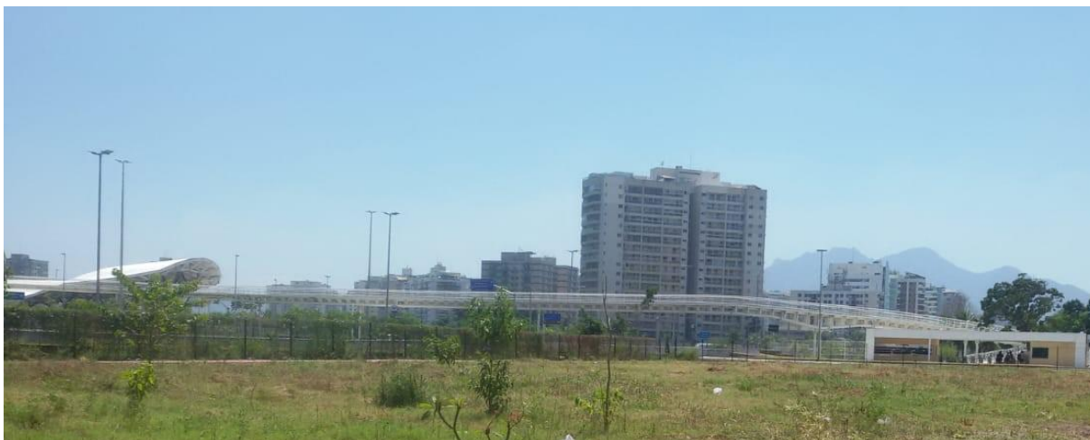
Foto 4 – Passarela que liga a plataforma do Terminal Centro Olímpico a bilheteria
