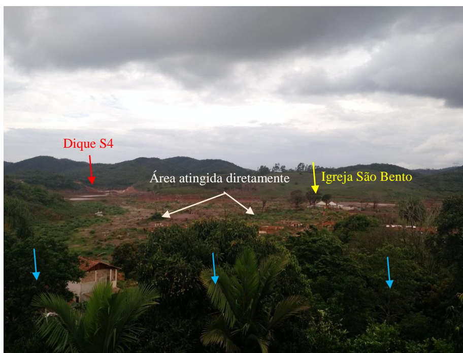
Fotografia 4 - Vista sobre o vale do Rio Gualaxo Bento Rodrigues (Mariana - MG) - Dique S4 e Igreja São Bento
