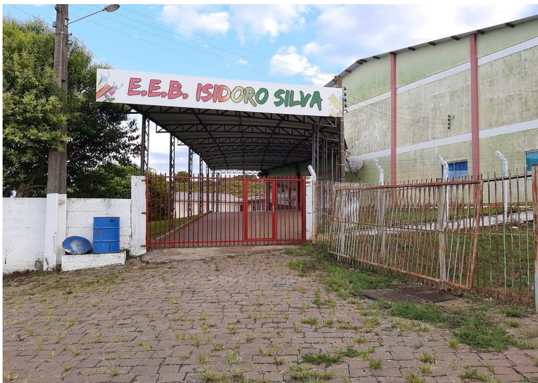
Vista externa da entrada principal da EEB Isidoro Silva. (Registro: Severine Macedo)
