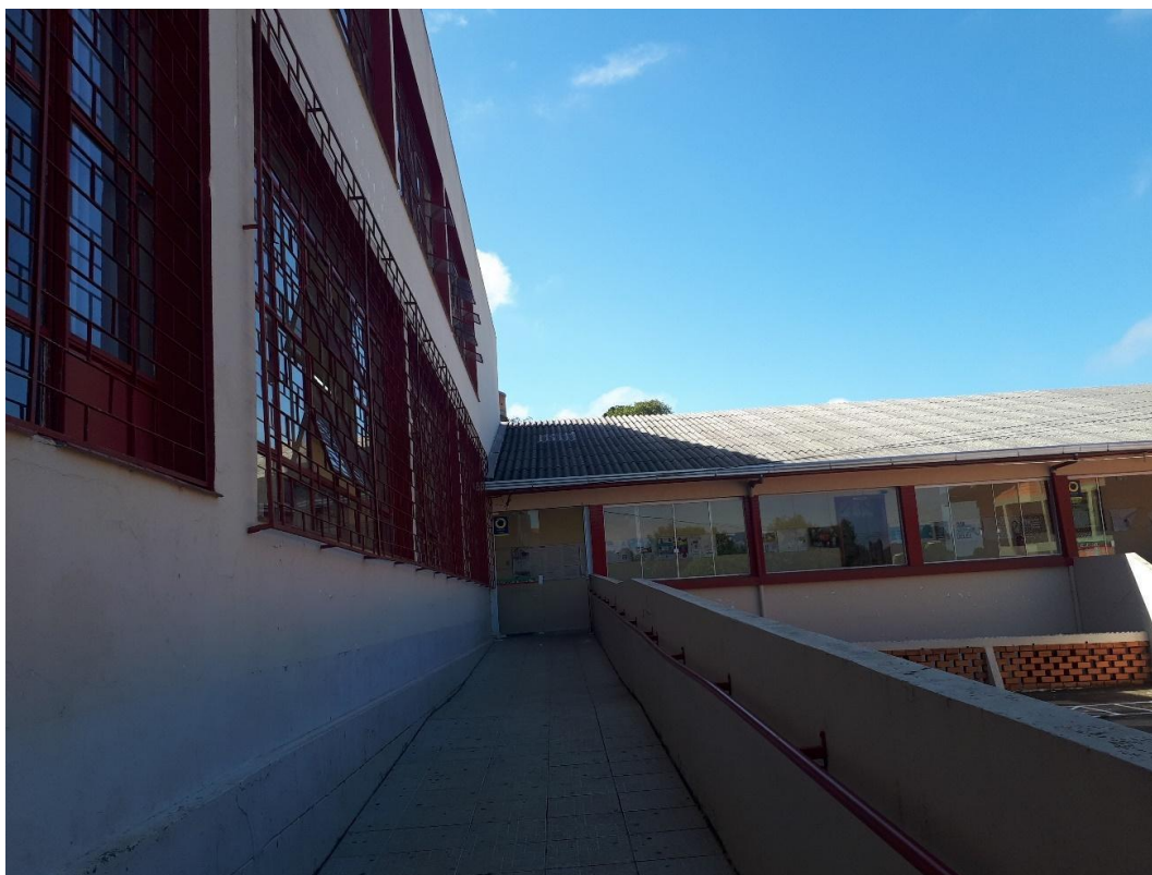
Rampa de acesso ao prédio principal da EEB Pe. Antônio Vieira. (Registro: Severine Macedo)
