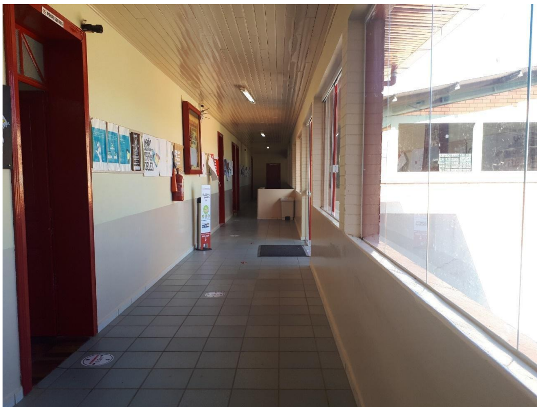
Corredor externo do prédio principal da EEB Pe. Antônio Vieira. (Registro: Severine Macedo)
