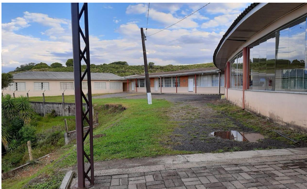
Vista externa da entrada principal da EEB Isidoro Silva. (Registro: Severine Macedo)
