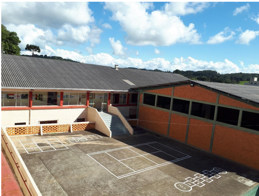
Entrada principal da escola e vista externa da quadra coberta da EEB Pe. Antônio Vieira. (Registro: Severine Macedo)
