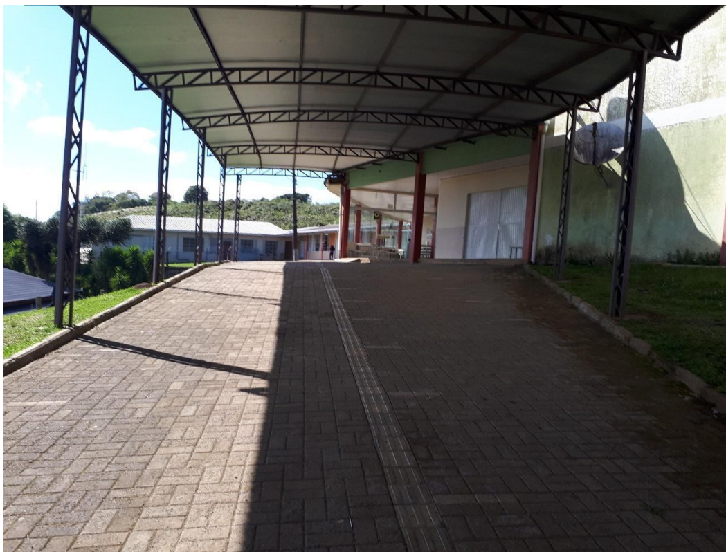
Acesso da entrada principal. (Registro: Severine Macedo)
