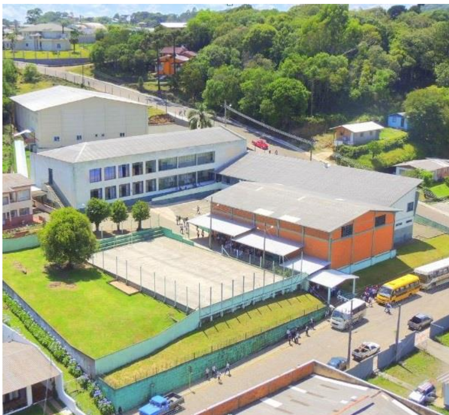
Foto 3 - EEB Pe. Antônio Vieira. Anita Garibaldi
