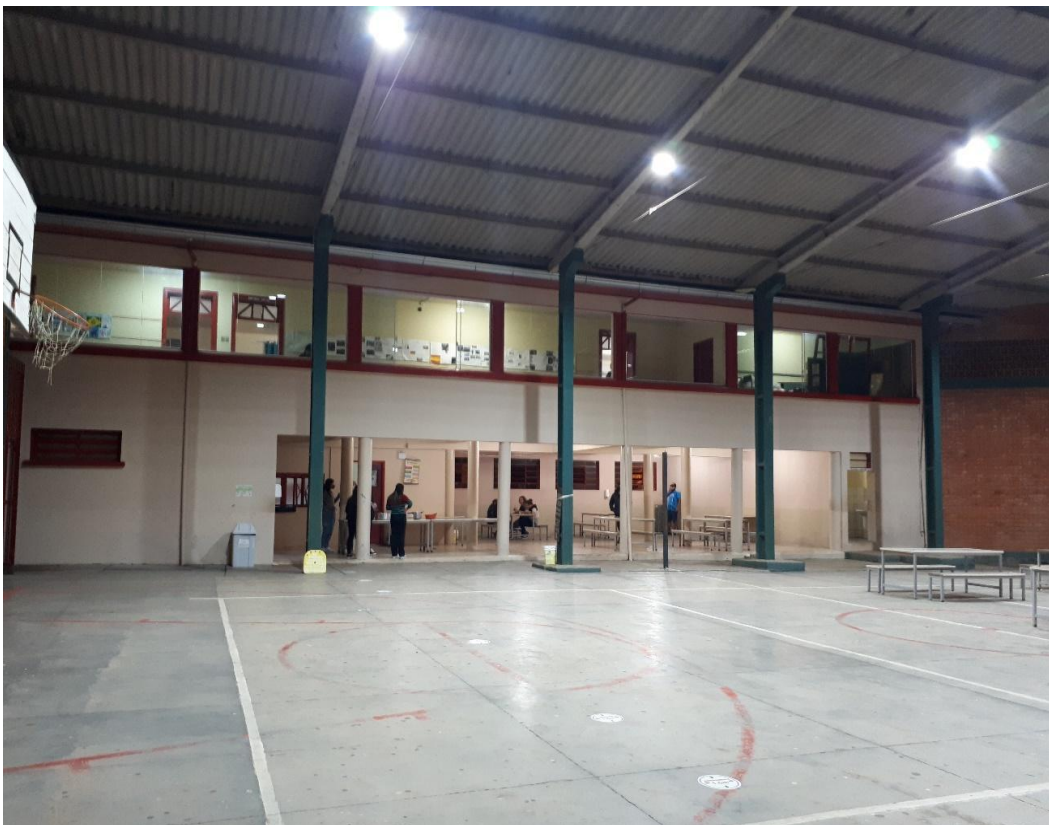
Parte interna da quadra coberta que serve também como refeitório. Ao fundo, local onde são servidas as refeições. (Registro: Severine Macedo)
