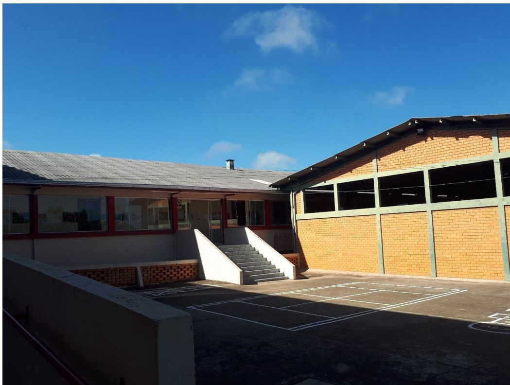
Entrada principal de acesso ao prédio principal da EEB Pe. Antônio Vieira. (Registro: Severine Macedo)
