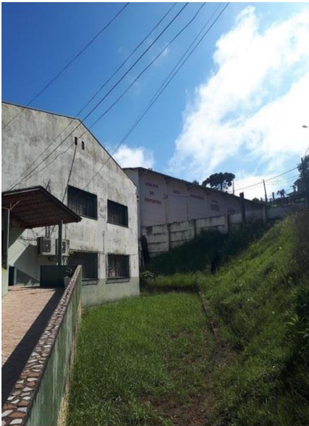
Vista dos fundos da EEB Pe. Antônio Vieira e do ginásio de esportes. (Registro: Severine Macedo)
