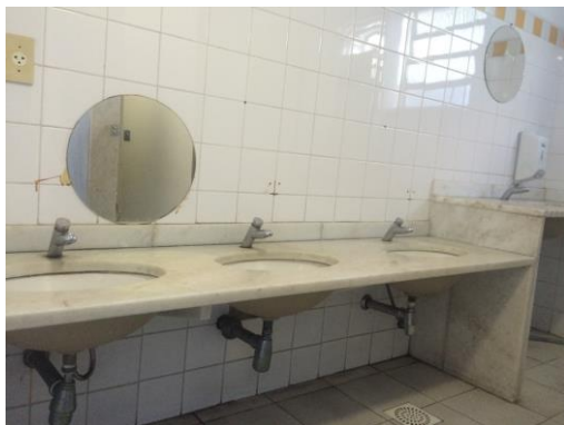
Foto 4.2.2.h. Banheiro do térreo
