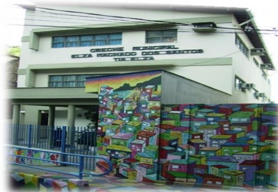
Figura 6. Fachada da Creche.
