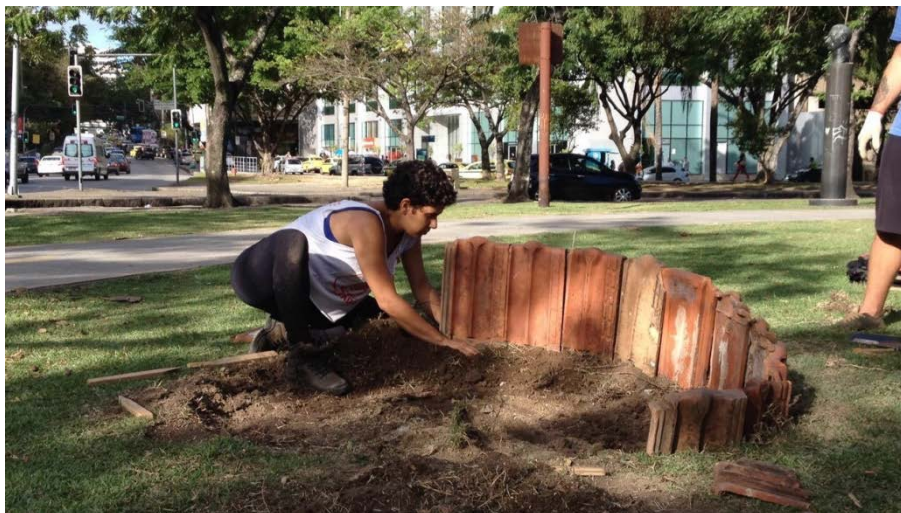
Figura 12 - Construção da espiral de ervas feita em telhas reaproveitadas
