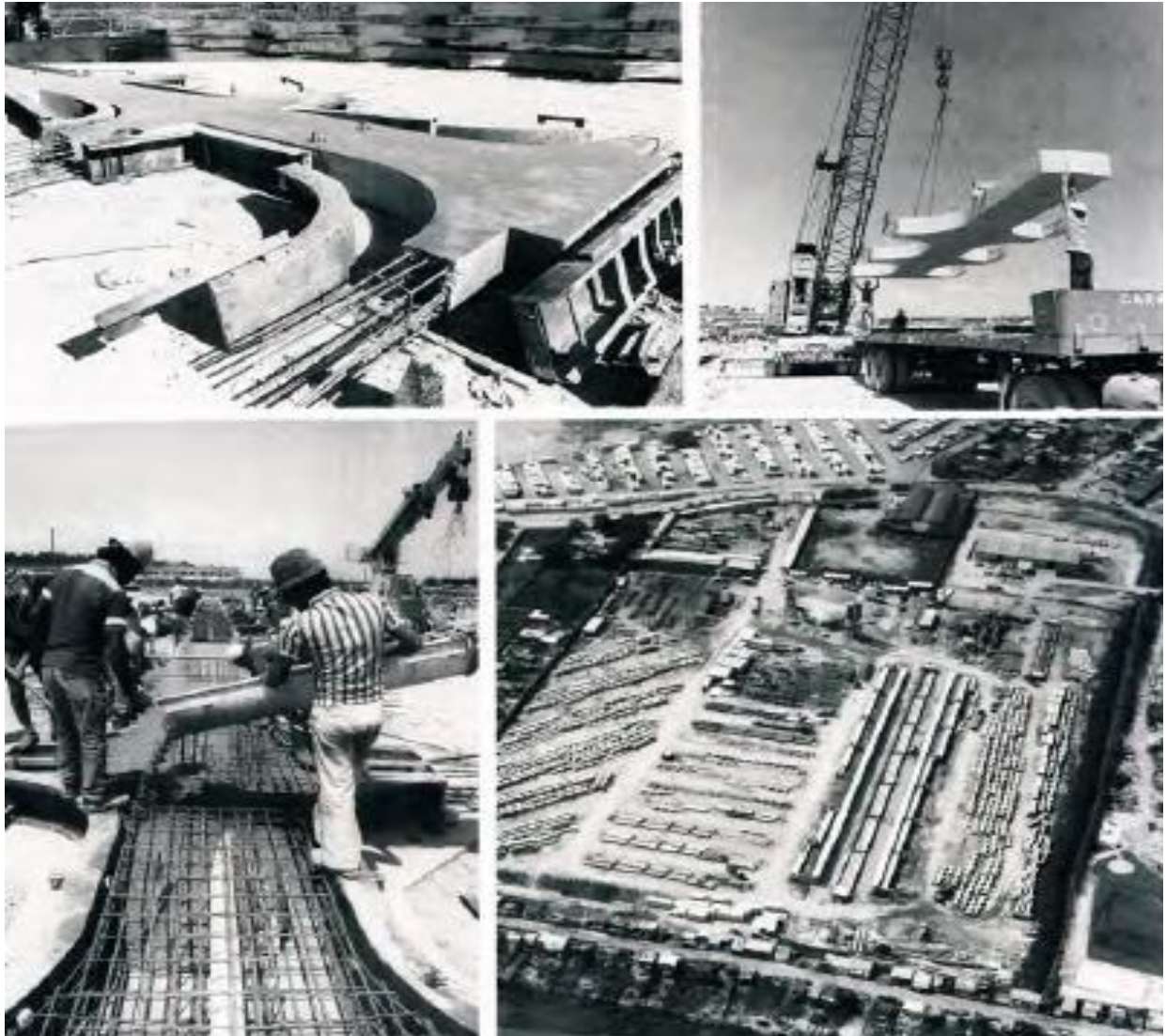
Imagem 5: CIEP em construção.
