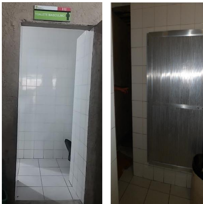
Fotografias 25 e 26 – Entrada do Sanitário masculino
