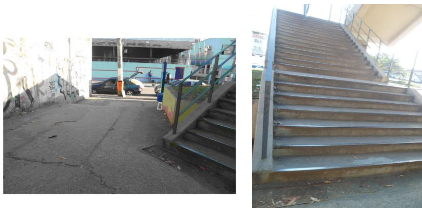
Fotografia 6 – Acesso C da Estação de Metrô- São Cristóvão
