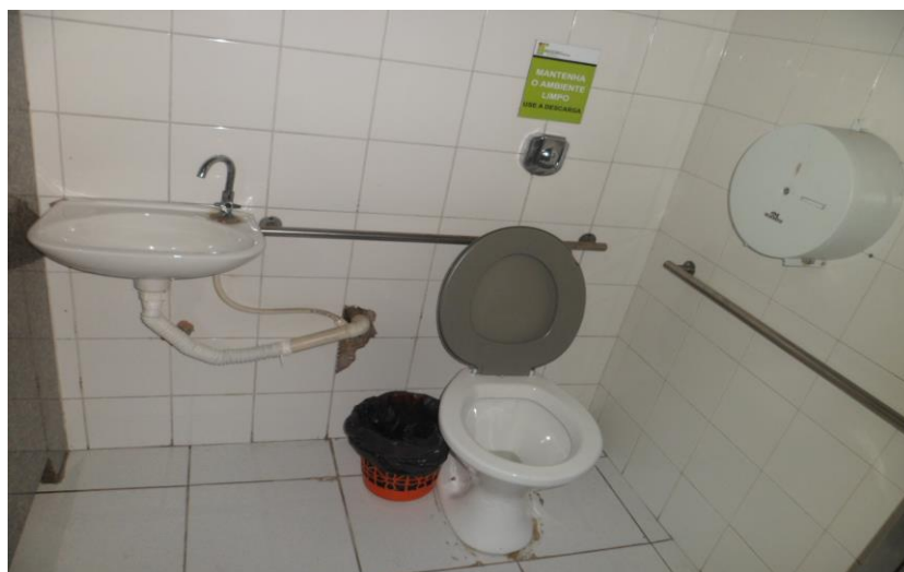
Fotografia 27 – Boxe do Sanitário masculino
