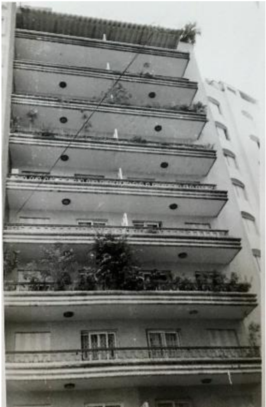
Imagem 18 – Edifício na Rua Maria Paula, esquina com a Rua Santo Amaro, Bela Vista. Projeto do arquiteto Artacho Jurado, estrutura em concreto armado com alvenaria de tijolos. São Paulo, 27 fev. 1992. Foto de Emerson. Acervo Departamento do Patrimônio Histórico, Fichas do Inventário Bela Vista.
