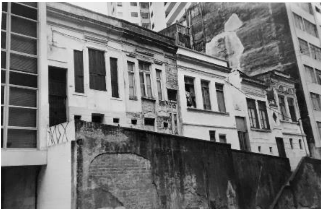
Imagem 16 – Conjunto de imóveis residenciais, utilizados como cortiço, na Rua Genebra, Bela Vista. Estilo eclético, erguido entre as décadas de 1910 e 1920. São Paulo, 19 mar. 1992. Foto de Emerson. Acervo Departamento do Patrimônio Histórico, Fichas do Inventário Bela Vista.
