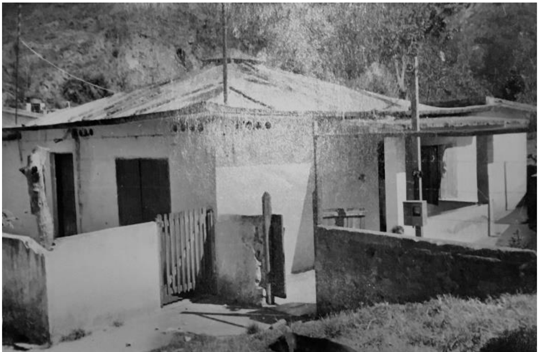
Imagem 21 – Exemplar da Vila Triângulo. Imagem incorporada ao Parecer Técnico (SÃO PAULO, 1992d). Acervo CONPRESP
