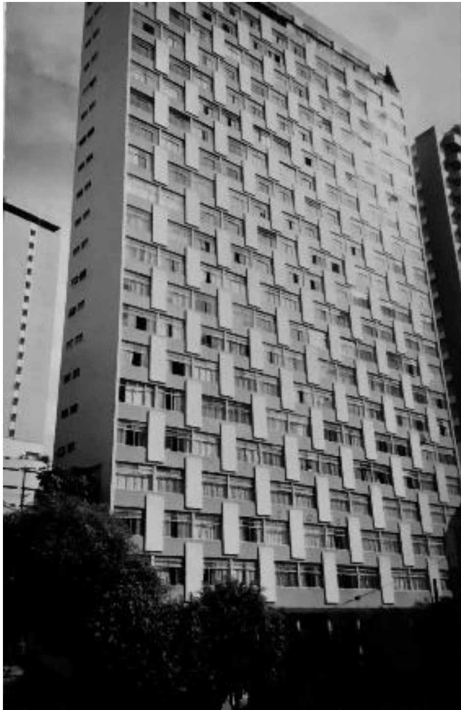
Imagem 17 – Edifício na Av. 9 de Julho, equina com a Rua Major Quedinho. São Paulo, nov. 2001. Foto de Paulo César. Acervo Departamento do Patrimônio Histórico, Fichas do Inventário Bela Vista.
