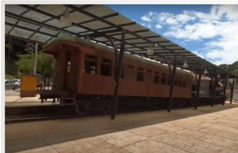
Figura 45 – Cobertura Planejada para a Locomotiva Zezé Leone
