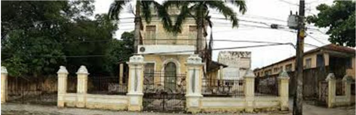
Figura 13 - Bloco A do Anexo II da Faculdade de Direito do Recife
