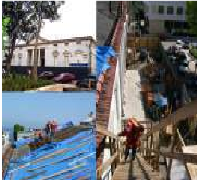
Figura 19 – Obra de Restauração do Paço Municipal, 2006. Autor: Hamilton Salgado. Fonte: Prefeitura de Manaus – Programa Monumenta – UEP.
