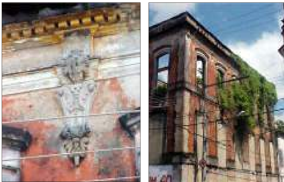
Figura 16 e Figura 17 – Detalhes das Fachadas degradadas do Hotel Cassina, 2002. Fonte: SEC – Ateliê de Restauro.
