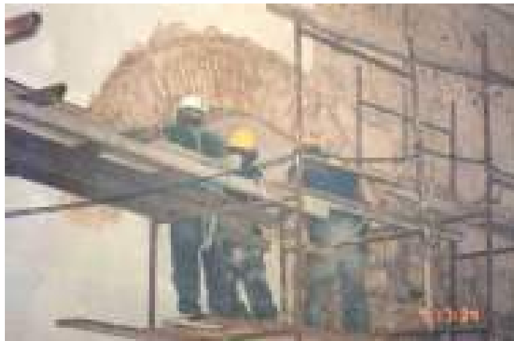
Figura 65 – Prospecções parietais na Sacristia, onde foi encontrado um arco pleno que interligava a Nave com a Sacristia e a cápsula do tempo, 2002.
