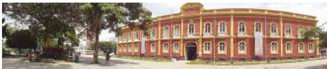
Figura 37 – Palacete Provincial, após a obra de Restauração, 2009.
