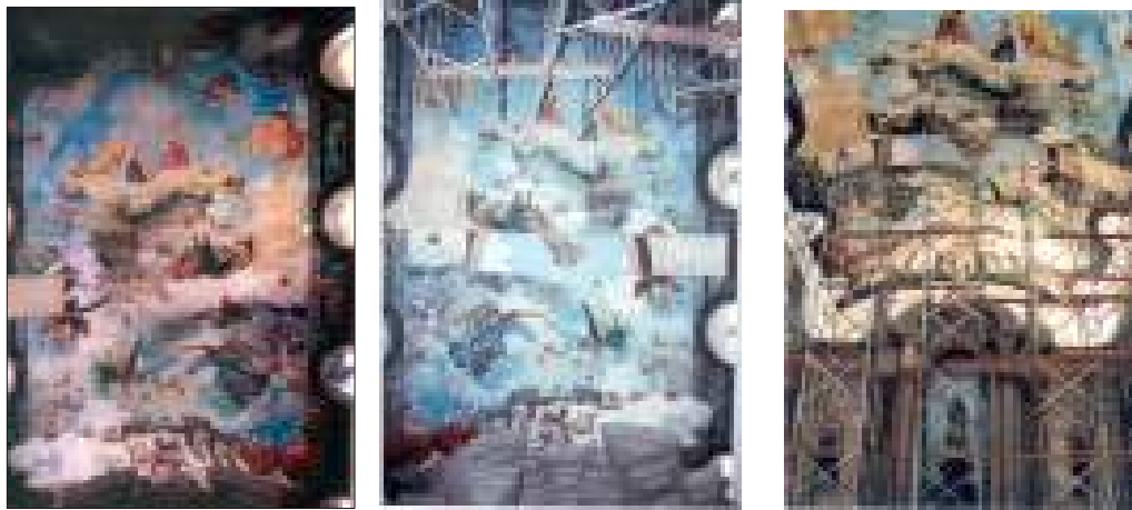
Figura 54, Figura 55, Figura 56 – Forro da Capela Mor, durante a obra de restauração, 2001. Autor: Alberto César Fonte: SEC - Ateliê de Restauo.
