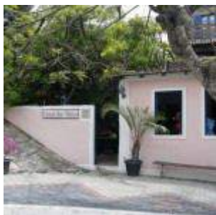
Figura 11 – Casa de Victorino Carriço. Fonte: Secretaria de Cultura do Estado do Rio de Janeiro.
