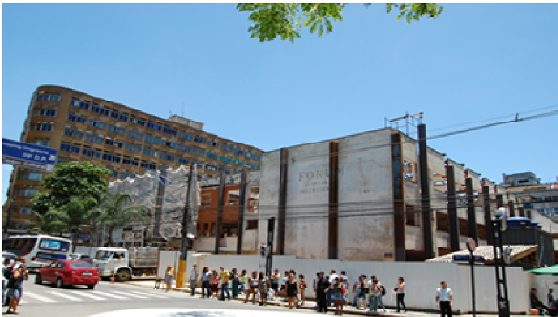
Imagem 7: Início do processo de demolição no prédio do Fórum em 2008 para a adaptação ao Museu Ciência e Vida.
