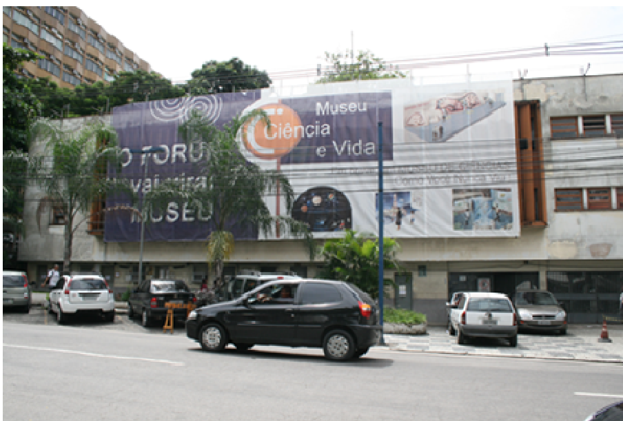
Imagem 8 : Início das obras no prédio do Fórum em 2008 para se transformar no Museu Ciência e Vida. (Fonte: Arquivos do Museu Ciência e Vida)
