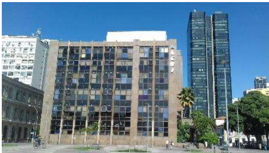
Figura 23: Prédio Anexo da Assembleia Legislativa – ALERJ e, ao fundo, o Edifício Cândido Mendes Foto da autora, 27 abr./2019
