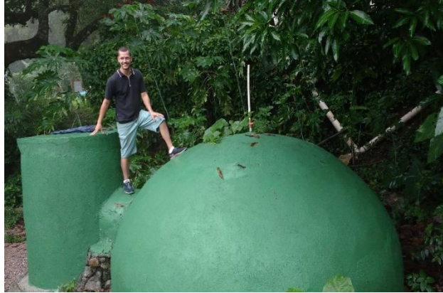
Figura 47. Biodigestor instalado abaixo da Comunidade Fonte: Beliani, 2016.
