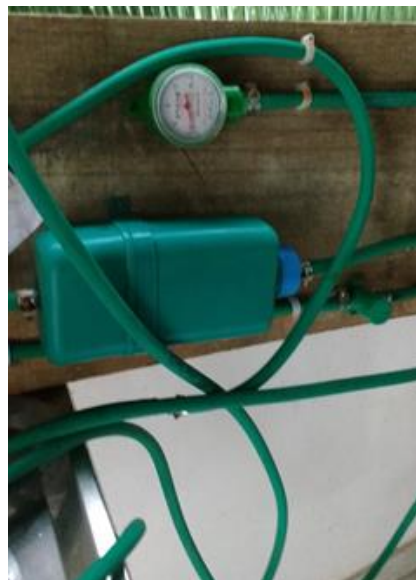
Figura 48. Canaleta para distribuição de gás para a Cozinha da COOVE Fonte: Beliani, 2016.
