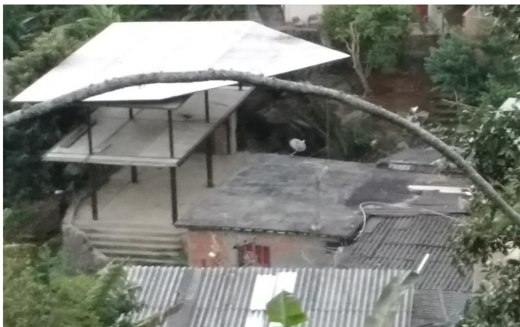
Figura 41. Vista do prédio em construção da AMATA Fonte: BELIANI, 2016.
