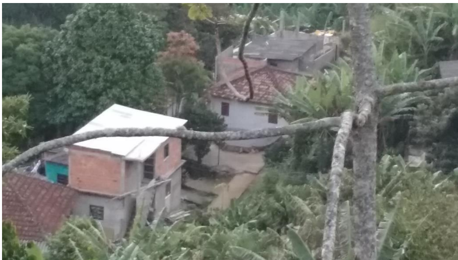
Figura 35. Vista a partir da laje da Cooperativa da Comunidade Vale Encantado Fonte: BARROS, MELO, 2011.
