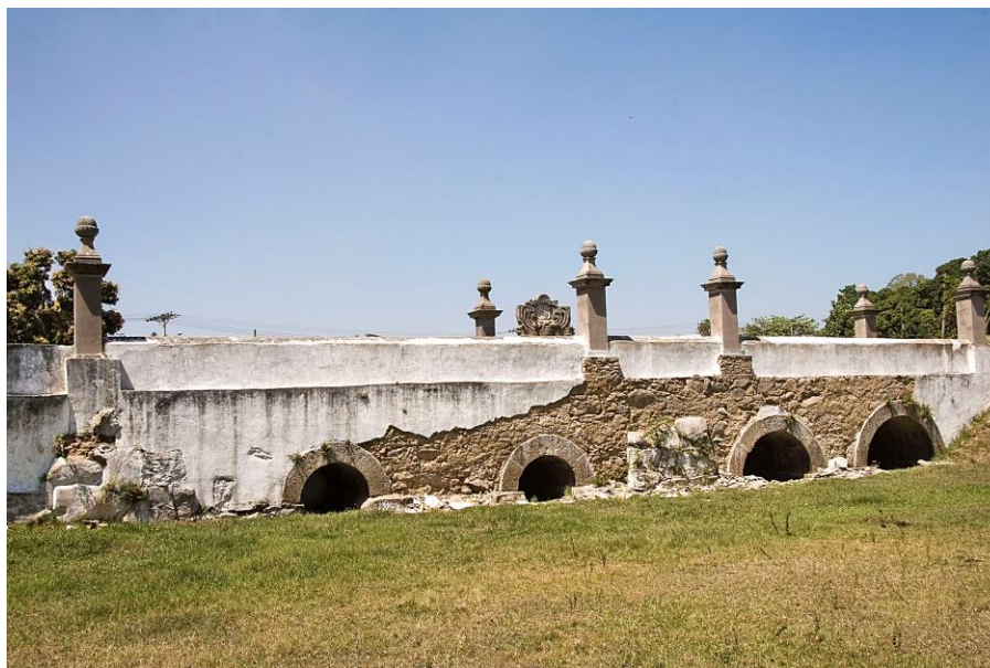
Figura 78 – Ponte dos Jesuítas , Santa Cruz, Rio de Janeiro (RJ).
