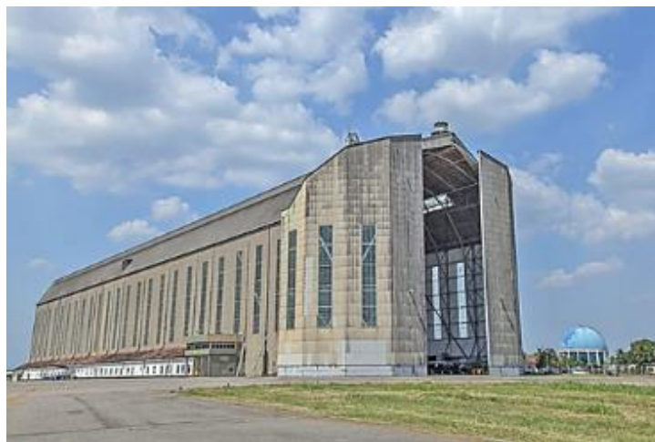
Figura 3 – Hangar dos dirigíveis. Base Aérea de Santa Cruz, Rio de Janeiro (RJ).
