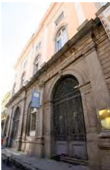
Figura 3 – Fachada do edifício do Centro Municipal de Arte Hélio Oiticica (CAHO) situado à rua Luís de Camões – Centro, Rio de Janeiro (RJ)
