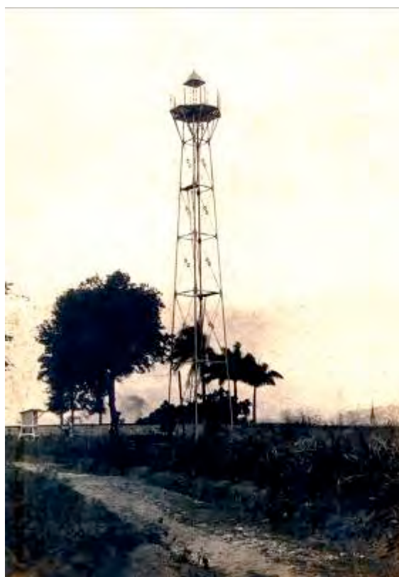
Figura 22 – Torre de difusão do sinal horário luminoso transmitido pelo Serviço da Hora realizado pelo Observatório Nacional. Fotografia: Autor desconhecido, s.d.
