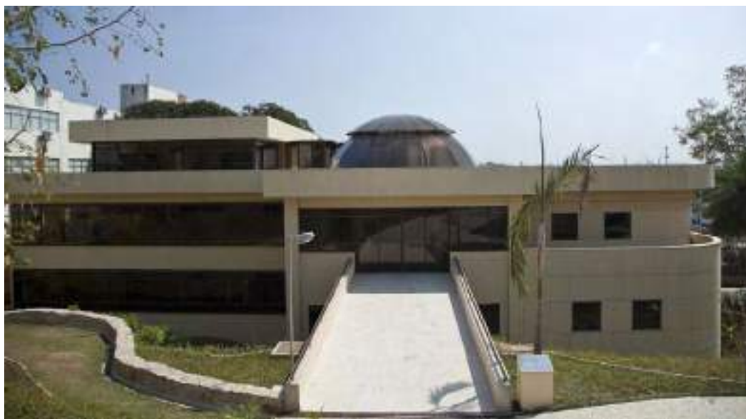
Figura 67 – Fachada principal do edifício anexo à sede do MAST. Acervo: Coordenação de Museologia (CMU/MAST/MCTI). Fotografia: Jaime Acioli, 2011.
