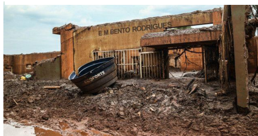
Figura 21: A Escola Municipal Bento Rodrigues, onde dezenas de alunos saíram às pressas. Agora não passa de um esqueleto em meio ao barro formado pela lama.
