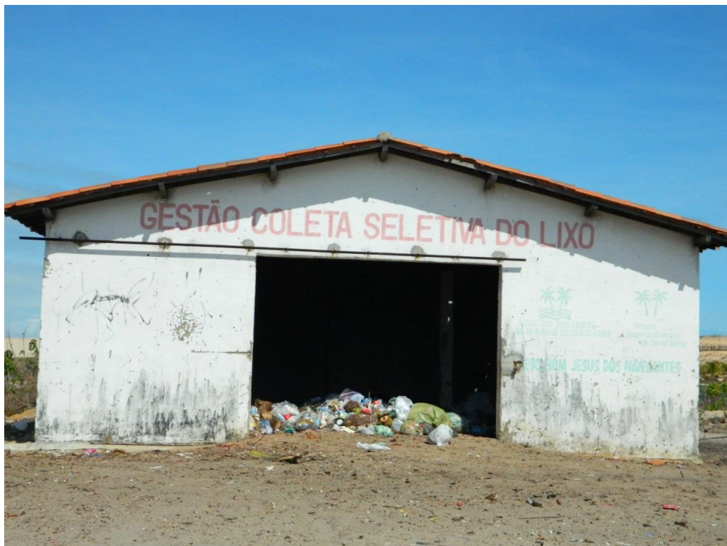
Figura 46: Galpão para depósito temporário do lixo/Praia do Canto Verde Acervo da autora/2013
