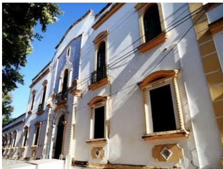
Figura 7 - Fachada do Museu de História natural da Universidade Federal de Alagoas
