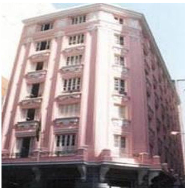
Figura 17 – Imagem do prédio da Biblioteca da Marinha. Foto: Acervo: DPHDM- Arquivo da Marinha
