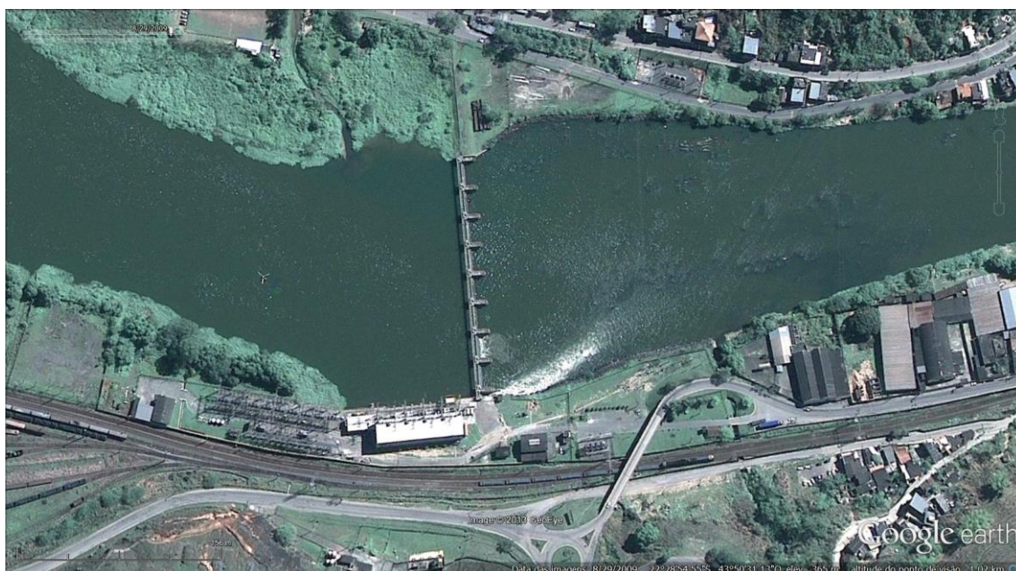
Figura 1. Usina Elevatória de Santa Cecília, responsável pelo desvio de parte das águas do rio Paraíba do Sul para o reservatório de Santana.
