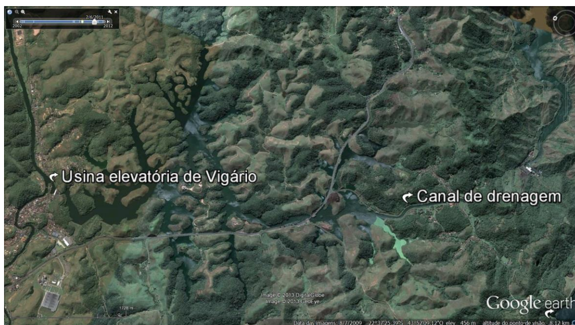
Figura 3. Reservatório do Vigário. Usina elevatória de Vigário à montante e canal de drenagem do reservatório à jusante.
