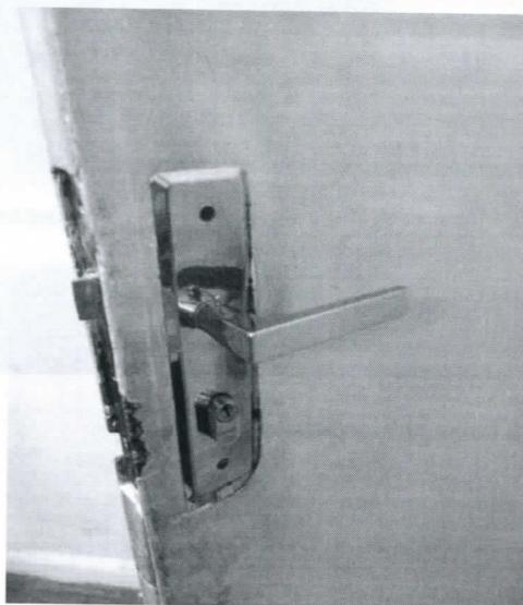
Fechadura e maçaneta em condições precárias.
