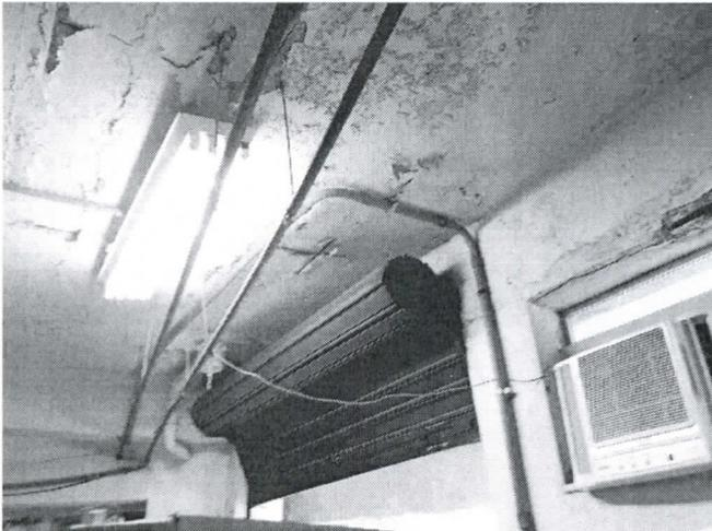
Umidade junto às instalações elétricas
