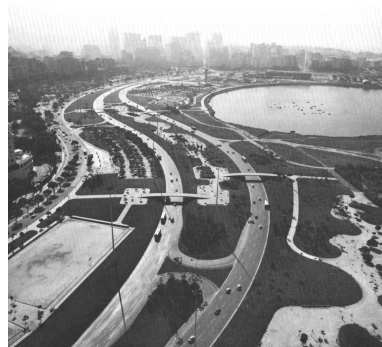
FIGURA 2 - ATERRO DO FLAMENGO COM SUAS 8 VIAS (DUAS PISTAS), HAVIA PROPOSTA DE UM SEGMENTO DE 16 VIAS (QUATRO PISTAS)
