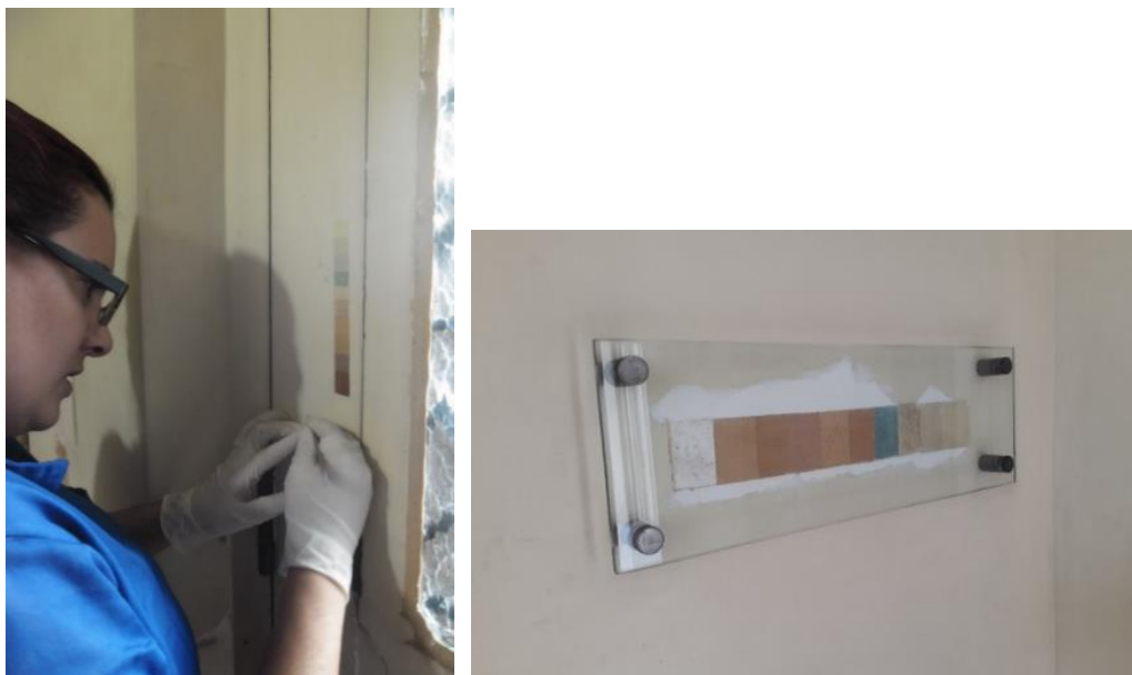
Figura 168: Prospecção pictórica parietal (Hall do elevador 1º pavimento)
