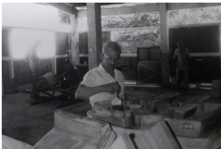
Figura A2.1: Mestre Adorcino Pereira da Silva confeccionando as tesselas e moldes para a fabricação dos estuques que compõem a Torre Norte
