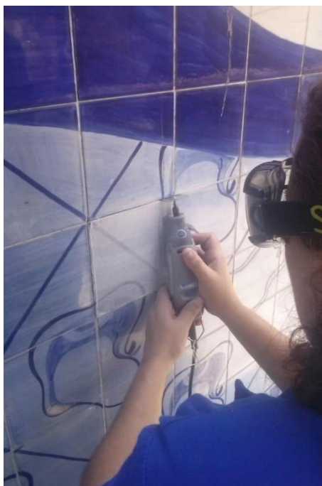
Figura 171: Plano de Conservação Preventiva do Pavilhão Arthur Neiva, desenvolvido pela COC/ DPH e The Getty Foudation.
