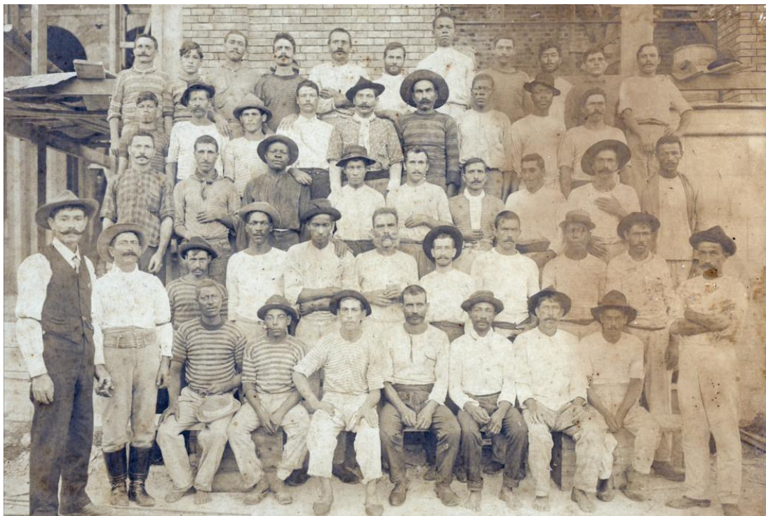
Figura 49: Trabalhadores do Pavilhão Mourisco
