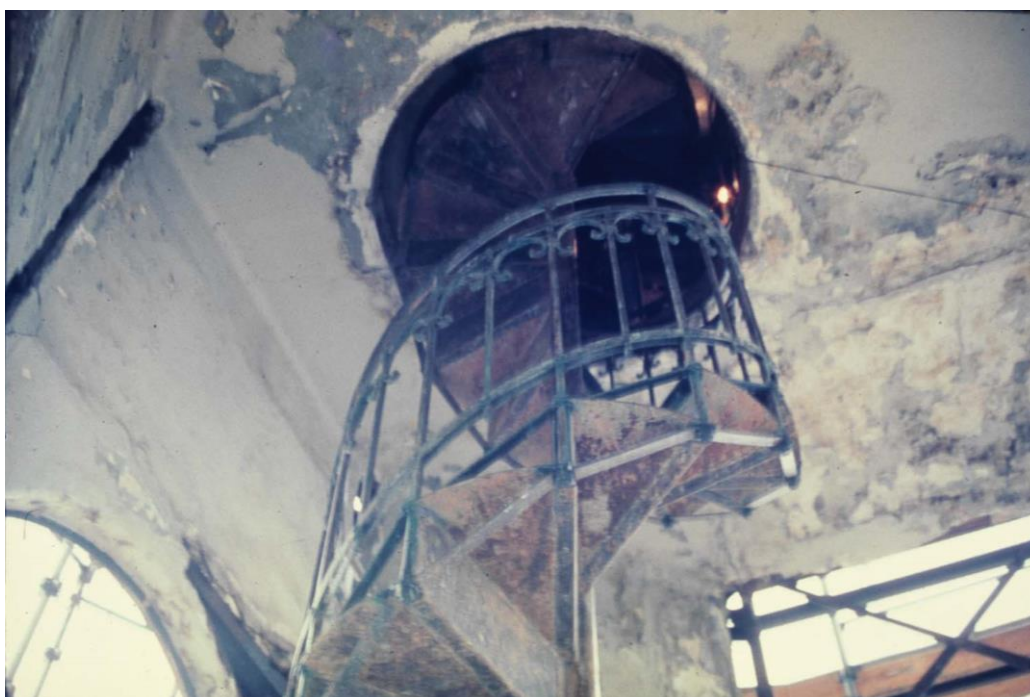
Figura 59: Obra de restauração da Torre Norte (Interna)
