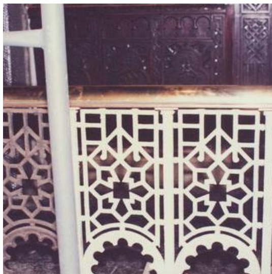
Figura 135: Teste de repintura no guarda-corpo no hall central do Pavilhão Mourisco.
