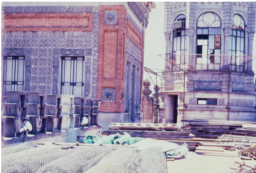
Figura 58: Obra de restauração da Torre Norte (Externa)
