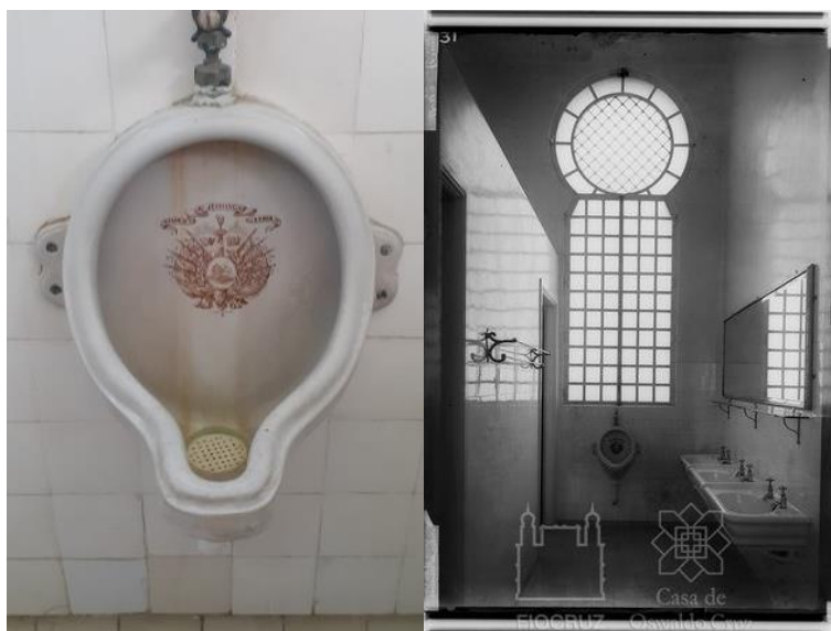
Figura 160: Banheiro do Pavilhão Mourisco, negativo de Vidro
