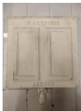
Figura 156: Caixa de descarga da G. Jennings, Londres
