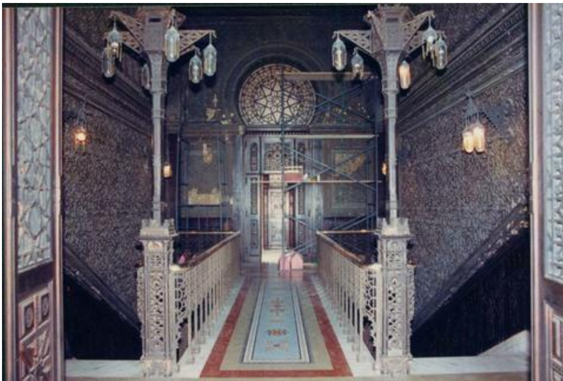
Figura 66: Hall central. Início da restauração
