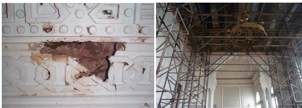
Figura 193: Desmontagem do forro estuque da BOR para extermínio dos xilófagos e tratamento do madeiramento
