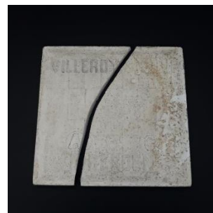
Figura 78: Azulejo da Villeroy & Boch (Danificado)
