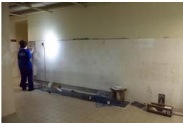
Figura 79: Conservação do Painel de azulejos do pavimento térreo do Pavilhão Mourisco.
