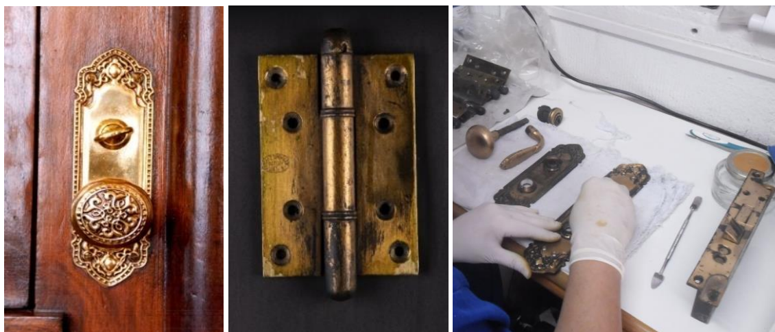
Figura 128: Limpeza das peças das ferragens das portas do Pavilhão Mourisco
