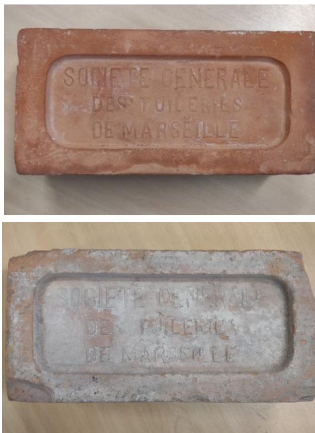
Figura 73: Tijolo Cerâmico com sujidades e presença de sais
