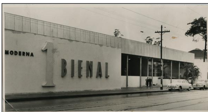
Figura 27: Imagem da fachada da mostra pioneira Fonte: http://www.concretosparalelos.com.br/?p=98
