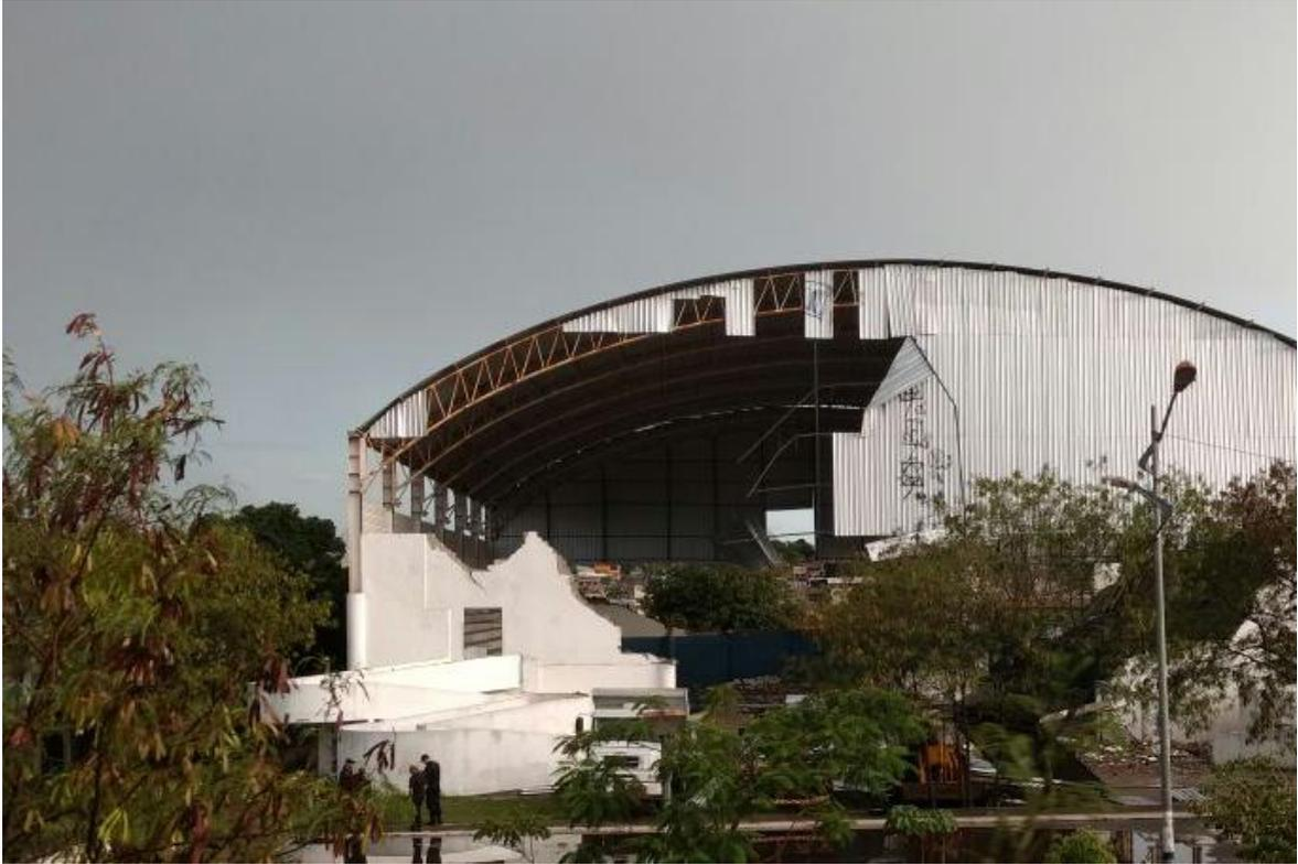
Figura 13 - Ginásio Municipal após o desmoronamento da estrutura que abrigaria a TAJJ
