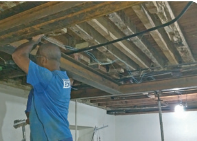
Reforço do piso da Reitoria
