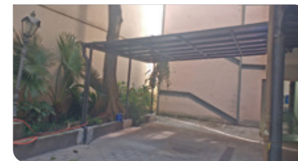
Esquadrias e cobertura CCJP
