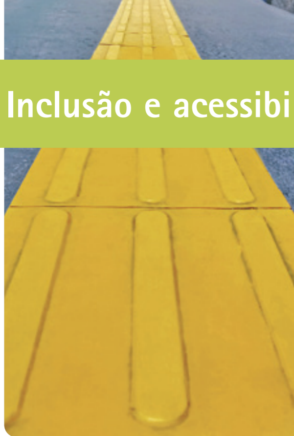
Detalhe do piso tátil no campus da Reitoria
