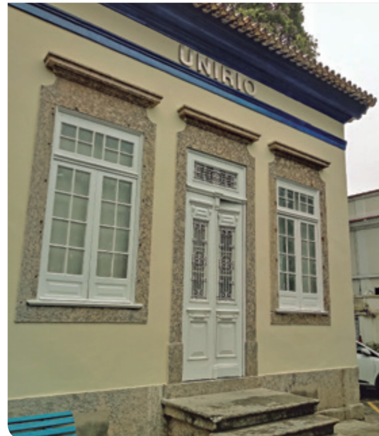
Fachada da sede da Prae, no campus da Reitoria
