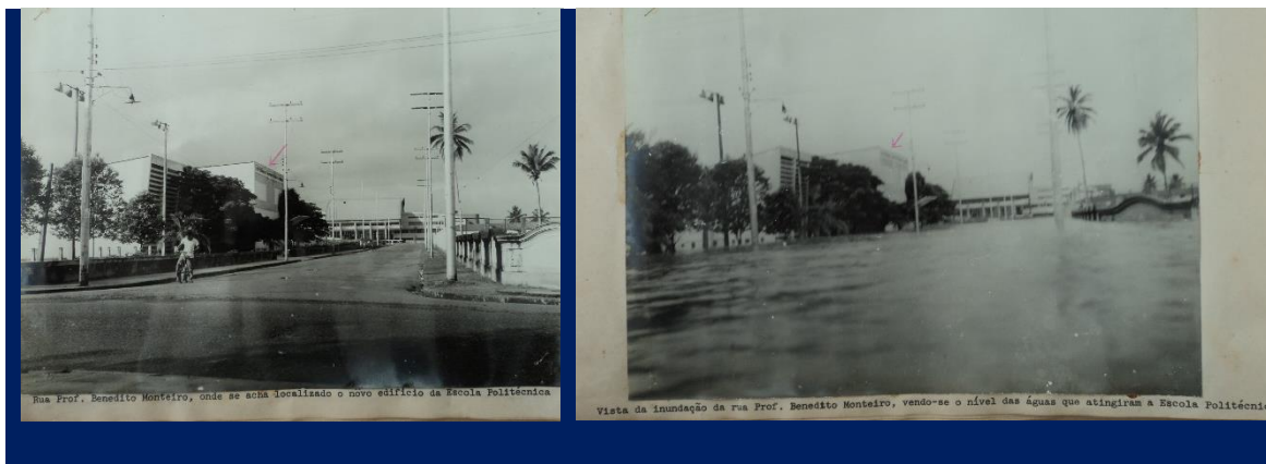
Figura 16. Perspectiva da Rua Benedito Monteiro antes e depois da enchente de 13 de junho de 1965. Fonte: ESCOLA POLITÉCNICA DE PERNAMBUCO, 1965, s/n.
