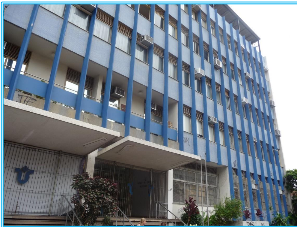
Figura 17 - Unidade R. Xavier Sigaud - Fachada da EEAP
