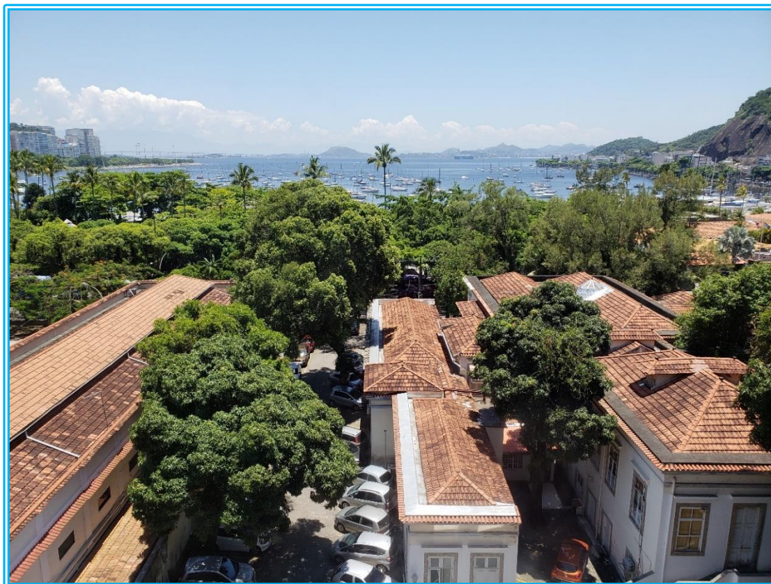
Figura 13 - Vista da Unidade Av. Pasteur, 296
