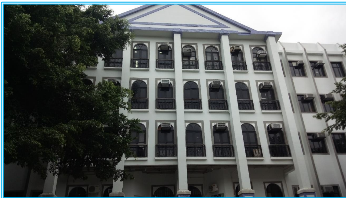
Figura 8 - Prédio do CCH
