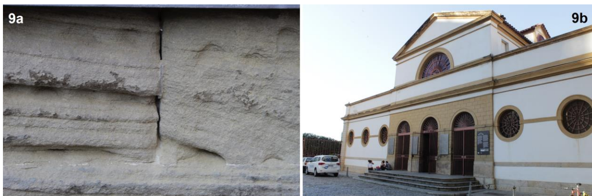
Figura 9: (a) Arenito Itararé, presente na fachada da Casa França – Brasil; (b) Fachada da Casa França – Brasil, Rua Visconde de Itaboraí, nº 78, Centro – Rio de Janeiro (Fotos: Bernardo Perrota, 2019).
