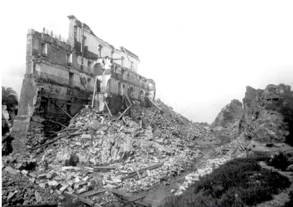
Figura 13: Demolição do Morro do Castelo. (Fonte: Rio de Janeiro, 2002).
