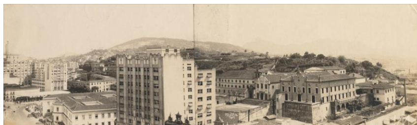
Figura 21: Morro de Santo Antônio antes da demolição (1922). (Fonte: Gilberto Ferrez. Disponível em: http://brasilianafotografica.bn.br/brasiana/handle/bras/2447 ).
