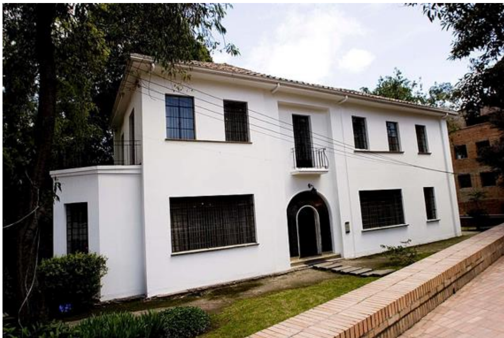
Figura 33 - Casa familiar de Jorge Eliécer Gaitán Ayala, atualmente Museu-Casa Jorge Eliécer Gaitán, Universidade Nacional da Colômbia - localizado na Rua 42 # 15-52, bairro Santa Teresita, 2014
