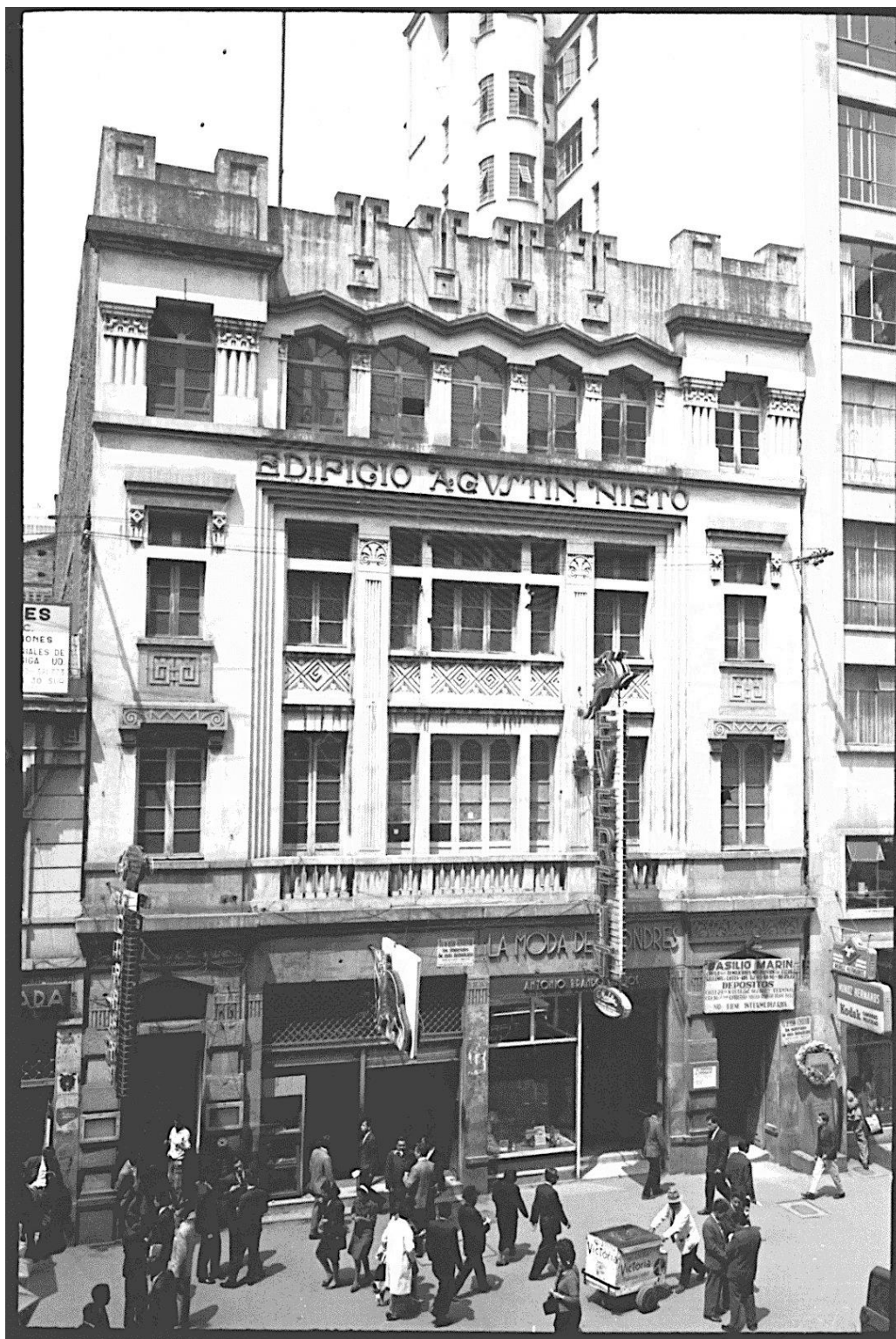
Figura 65 – Edificio Agustín Nieto. Carrera 7ª # 14 – 35, Bogotá D.C.
