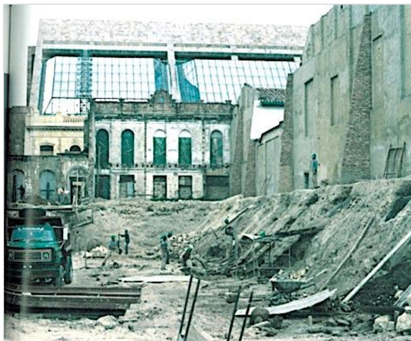
Figura 44 – Construção do novo edifício da Sede Central da FUAC (Sede XX Aniversário), nos antigos lotes ocupados pela casa (4–42, 4–34 e 4-32) geminada de dois andares e a Casa (4–30) de um andar, que faziam parte da antiga Clínica Central, 1989
