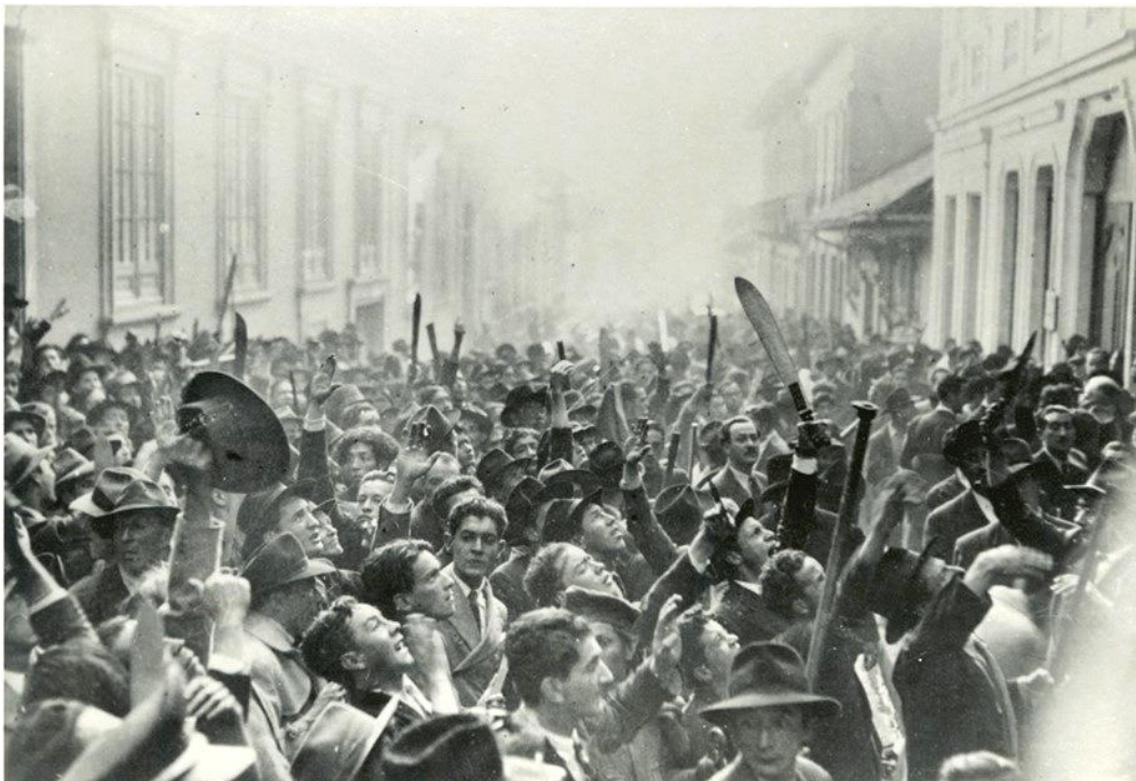
Figura 67 – Gaitanistas exigindo saber a sorte do seu líder na frente da Clínica Central, do lado esquerdo, o edifício do Ministério do Governo se incendiando
