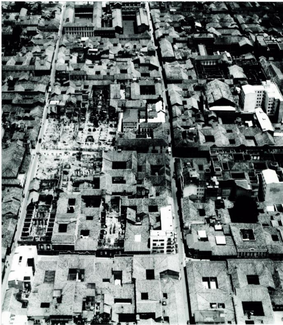
Figura 26 – Fotografia aérea do centro de Bogotá, de baixo para cima, de forma horizontal, se pode ver como ficaram as ruas 12ª, 11ª, 10ª e 9ª, entre a Carreras 4ª e 5ª -de esquerda à direita (de maneira vertical). Na fotografia aparecem as três casas que integravam a Clínica Central, vôo B-62, 29 abril de 1948
