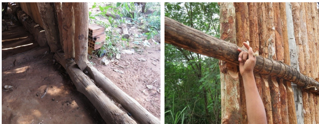
Figura 16: Arquitetura de troncos na aldeia Central do povo Balatiponé-Umutina: paredes de madeiras roliças apoiadas sobre tronco no solo, e amarrados na viga superior
