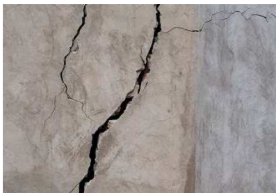
Fissura em camada pictórica.
