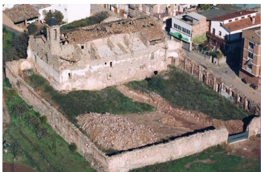
Figura 66 – Foto da demolição do convento de Sant Francesc.
