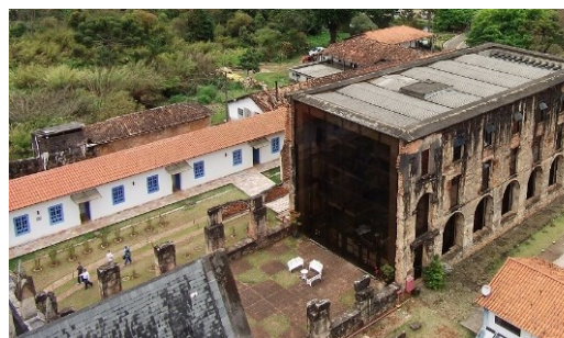
Figura 58 – Foto aérea da intervenção realizada na ruína do antigo colégio.
