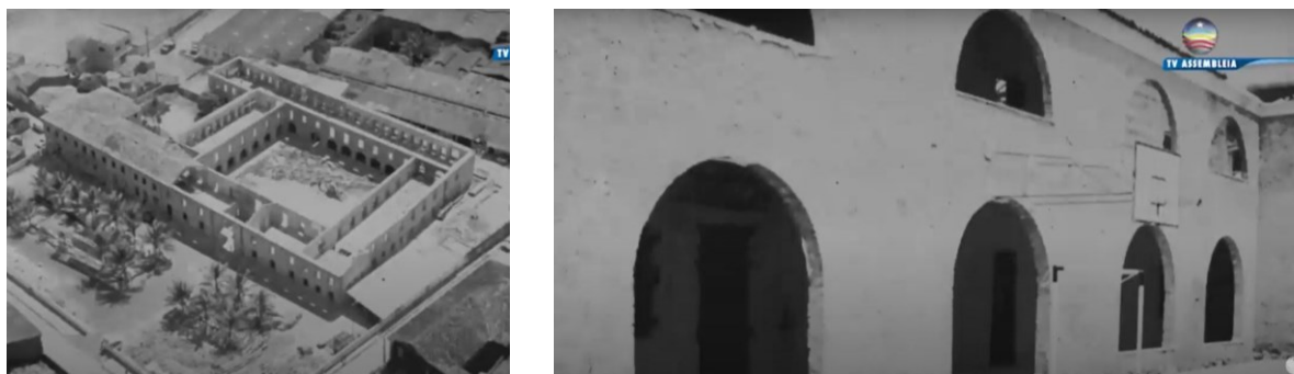
Figura 34 – Antigo Convento das Mercês, utilizado como quartel da polícia militar foi deixado em estado de arruinamento.
