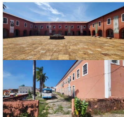
Figura 36 – Convento das Mercês, vista do claustro interno e do pátio posterior.
