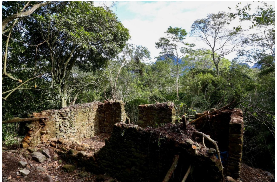
Figura 3. Vista de toda ruína da casa-grande da Pedra Bonita. Fonte: Os autores (2022).
