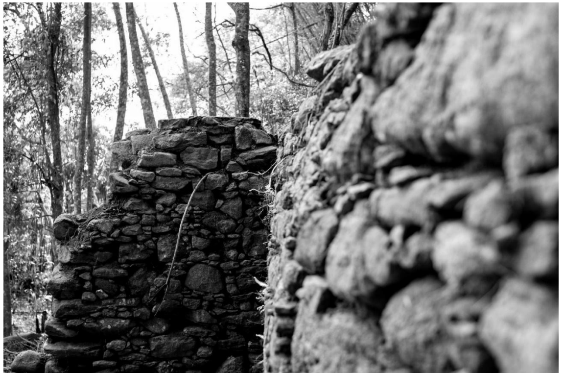
Figura 5. Paredes em pedra das ruínas da casa-grande da Pedra Bonita. Fonte: Os autores (2022).
