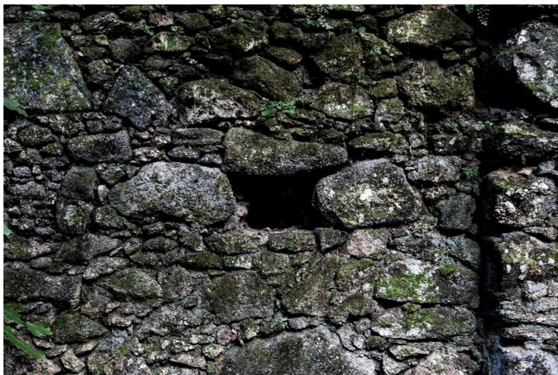
Figura 11. Detalhe do material (rocha gnaisse) utilizado na construção da parede de pedra. Fonte: Os autores (2022).
