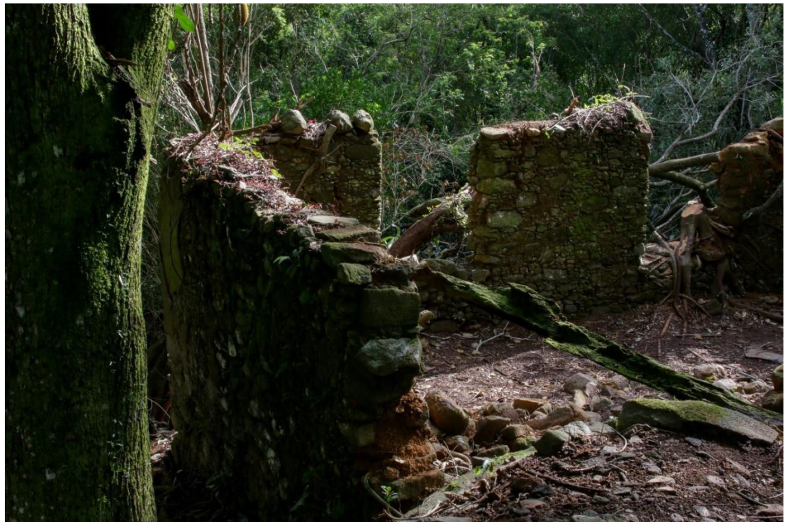
Figura 7. Paredes de pedra da ruína da casa-grande da Pedra Bonita, com detalhe para madeira equilibrada nas pedras, que possivelmente fazia parte do piso do segundo andar da casa. Fonte: Os autores (2022).
