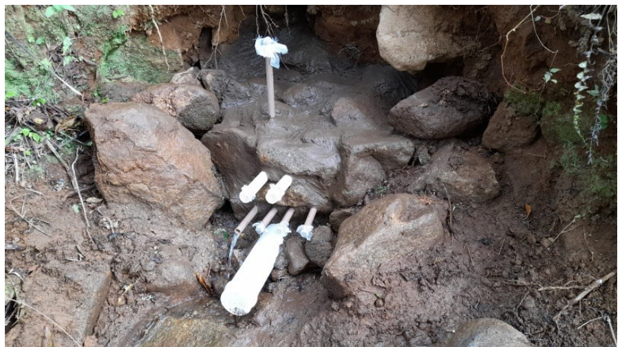
Figura 5. Sistema Caxambu para recuperação e preservação de nascentes. Foto: Elias Arruda.
