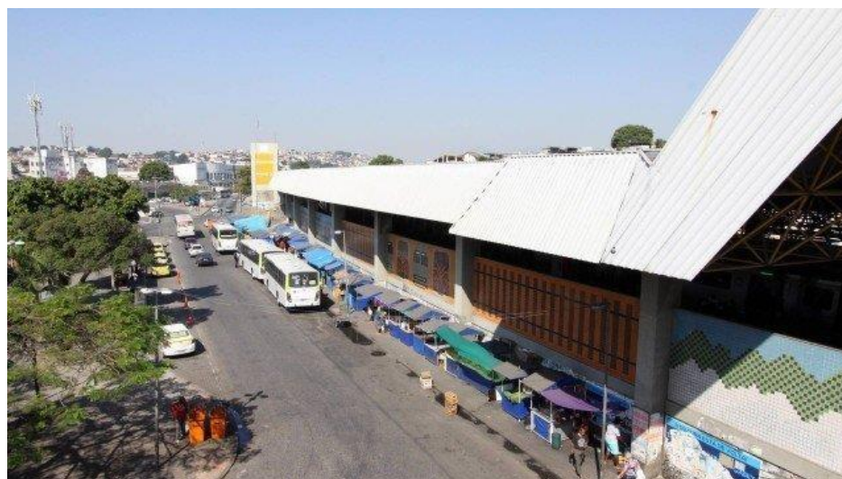
Figura 01 - Estação Metrô Pavuna, em 10/06/2020
