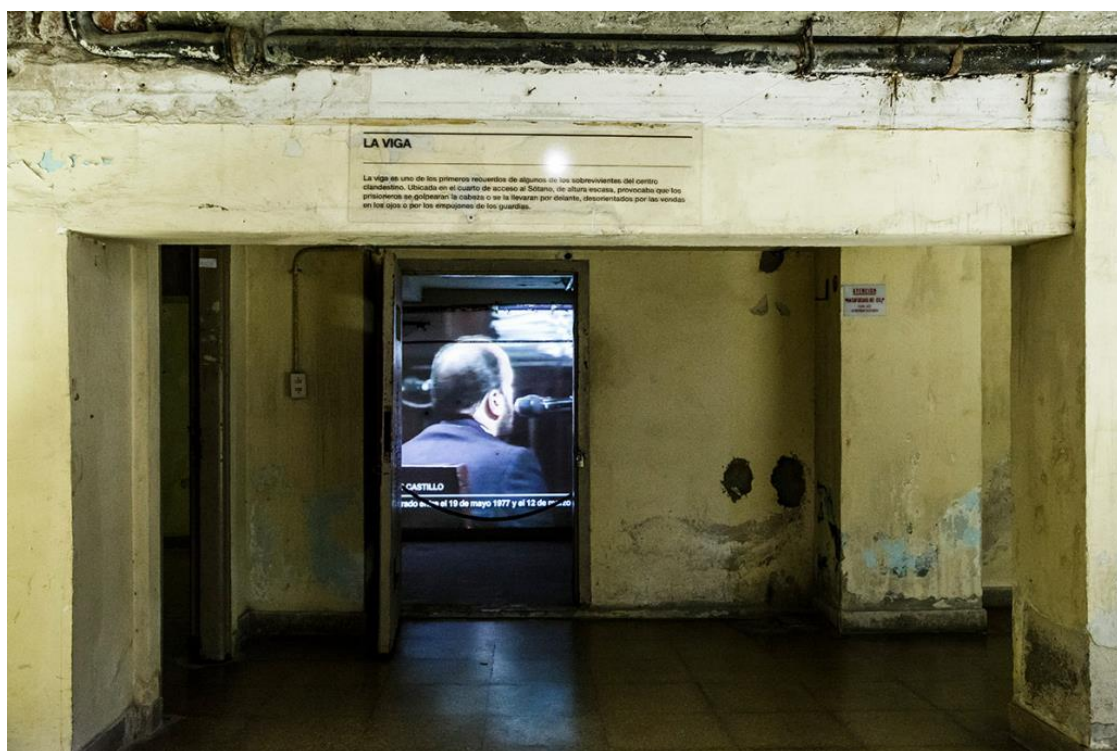
FIGURA 35 - PROJEÇÃO DE TESTEMUNHOS NO PORÃO (SÓTANO).
