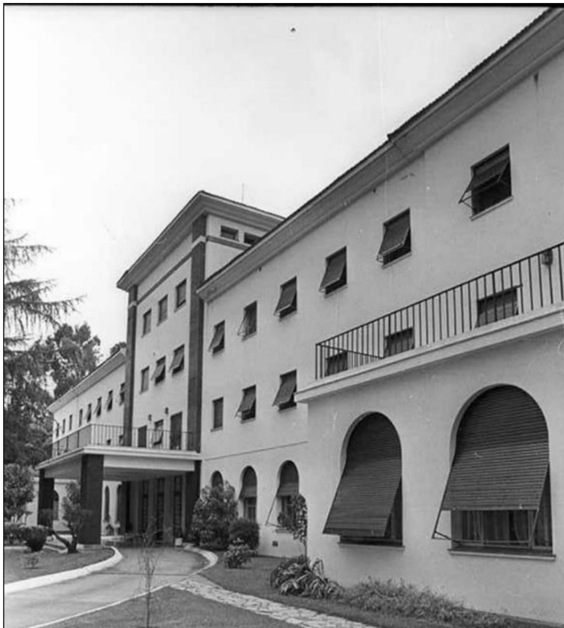
Figura 7 - Fachada do Casino de los Oficiales .
