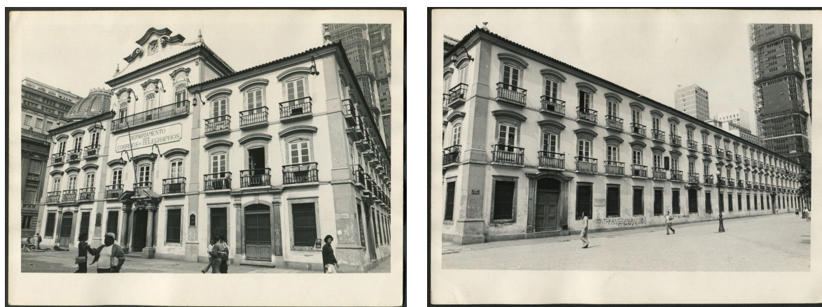
Figura 18: Fachadas do edifício do Paço da Cidade, sede dos Correios e Telégrafos em 1980. Ao fundo, vê-se o edifício Cândido Mendes em construção. 551
