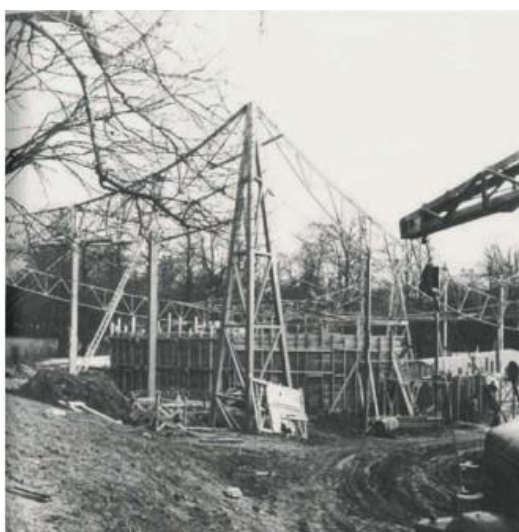
Figura 16 Montagem do pavilhão brasileiro.
