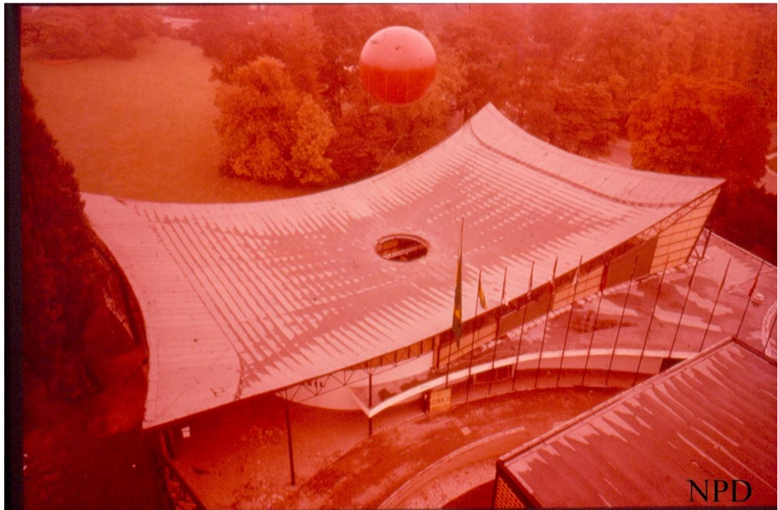
Figura 17 Vista superior do Pavilhão Brasileiro.
